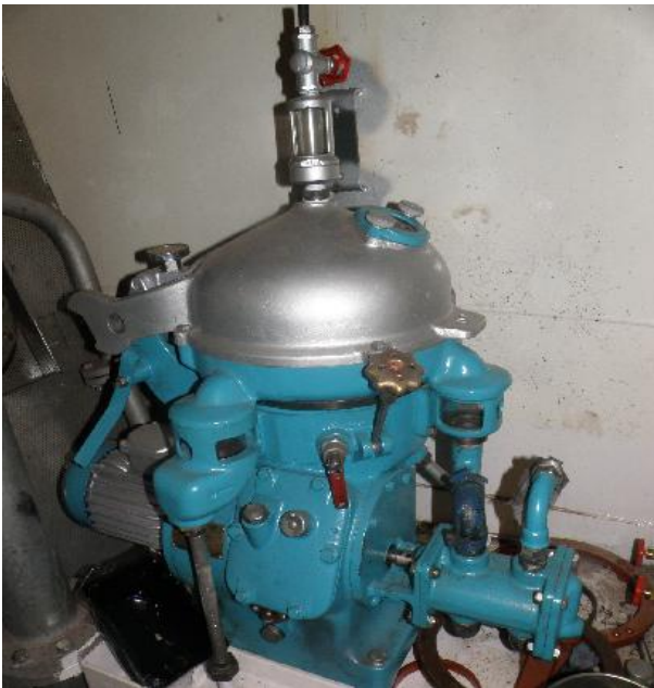
Kuva 3. Voiteluöljyseparaattori
