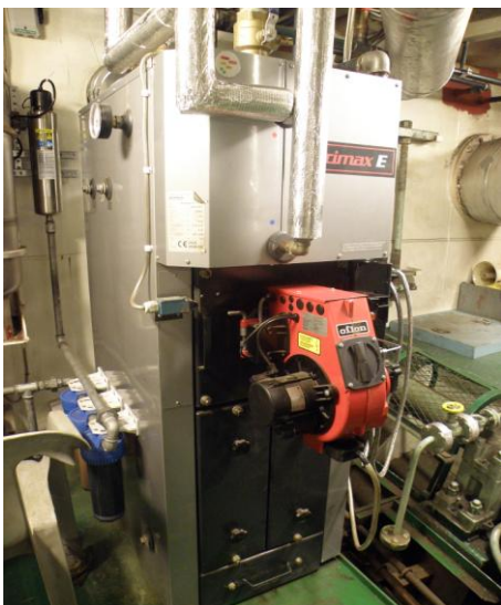
Kuva 7. Kattila ja poltin
