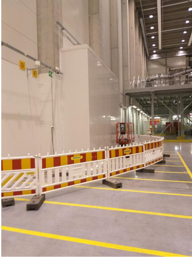
Kuva 6. Kuvassa rajattu alue ja rakennettu suojakoppi
