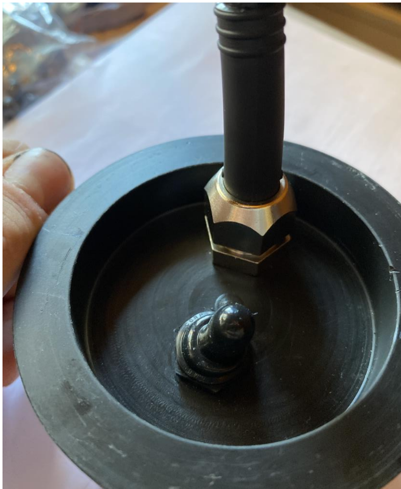
Kuva 15. Kytkin ja läpivienti sekä johto asennettuna
