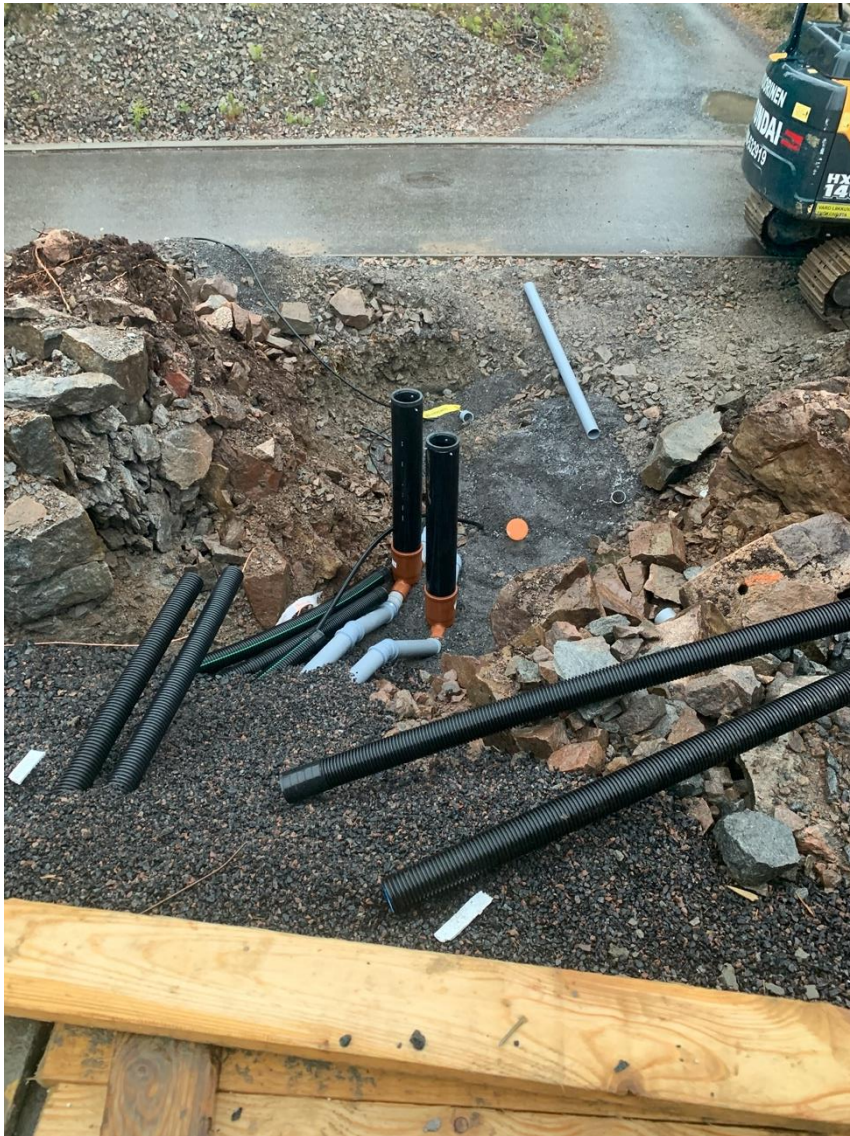
Kuva 3. Viemärin ja huleveden yhde Hirvensalossa.
