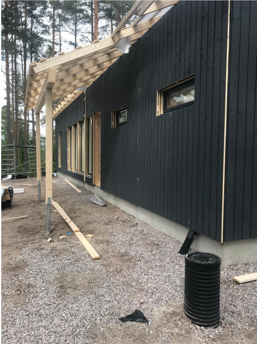
Kuva 2. Hulevesikaivo sokkelia vasten Paimiossa.
