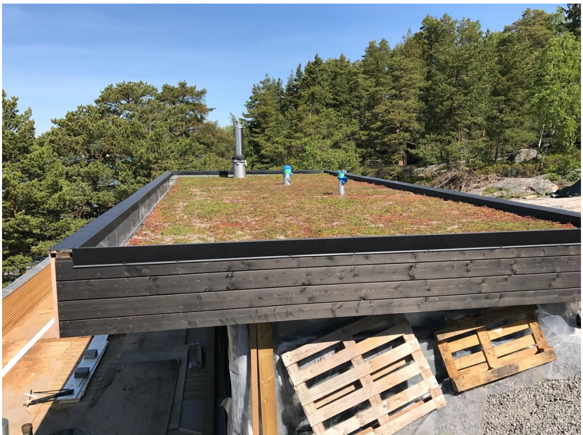
Kuva 6. Viherkatto kuvattuna asunnon päädystä.
