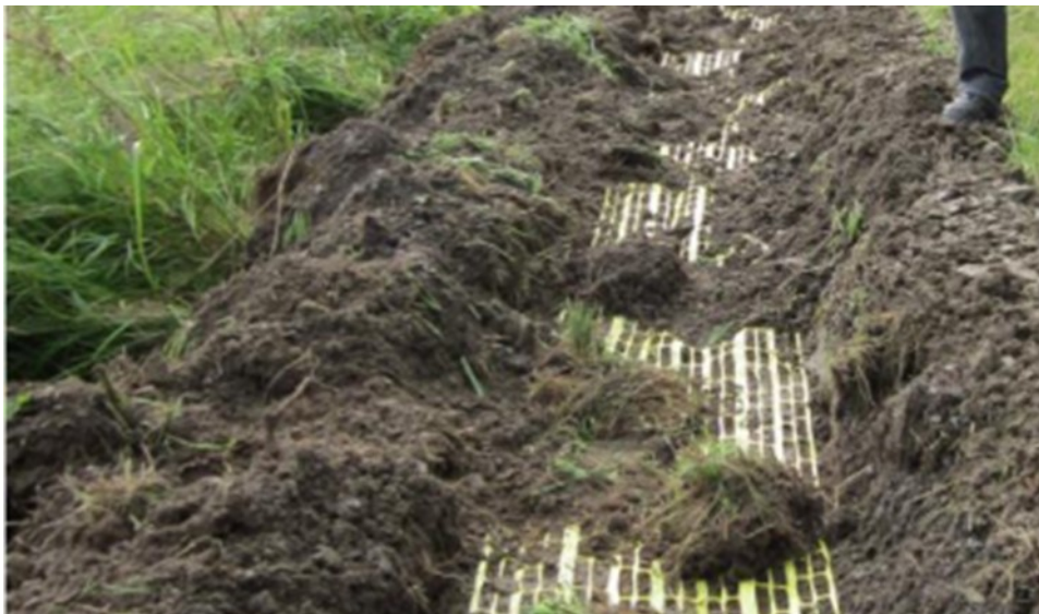
Kuva 6. Esimerkki sähkökaapelin päälle asennettavasta varoitusverkosta (ELY-keskuksen valokuva, n.d.).
