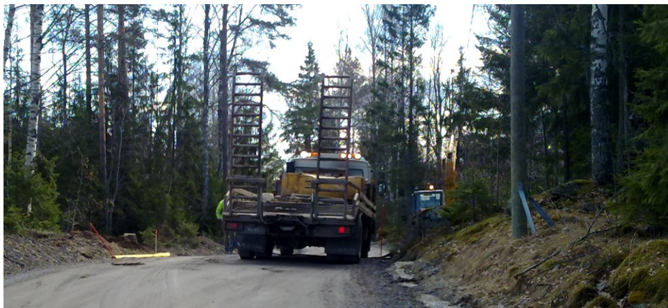
Kuva 8. Esimerkki puutteellisista liikennejärjestelyistä (ELY-keskuksen valokuva, n.d.).
