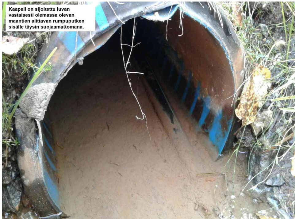
Kuva 7. Esimerkki luvan vastaisesti sijoitetusta kaapelista (ELY-keskuksen valokuva, n.d.).
