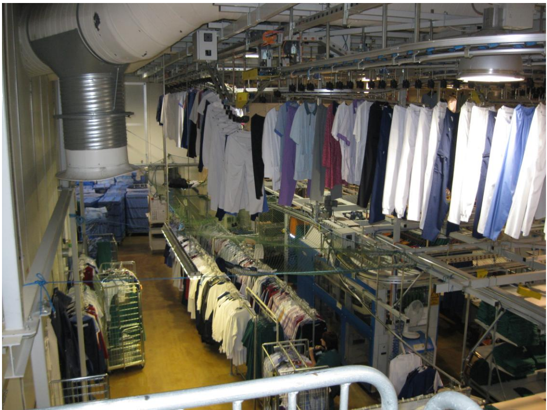
KUVIO 6. Osa työvaatteiden kattoratajärjestelmää
