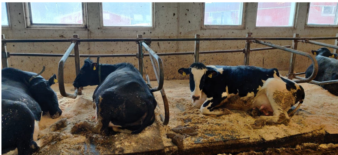
KUVA 18. Lisää rikkoutuneita parsikalusteita (Katainen 2020-03-05.)
