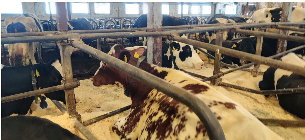
KUVA 16. Rikkoutuneita parsikalusteita (Katainen 2020-03-05.)
