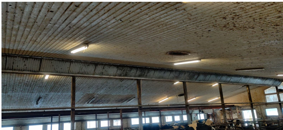
KUVA 25. Sisäkaton harjalla olevat itkupinnat sekä poistohormeja (Katainen 2020-03-05.)
