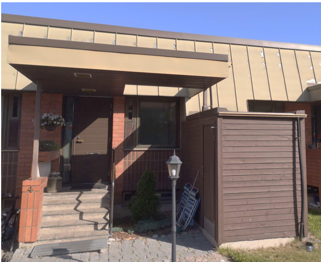
Kuva 29. Sisäänkäynnin nykyinen katoslippa (Kuva: A-Insinöörit Suunnittelu Oy)
