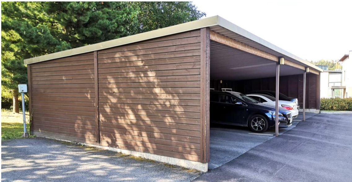
Kuva 12. Autokatos (Kuva: A-Insinöörit Suunnittelu Oy)
