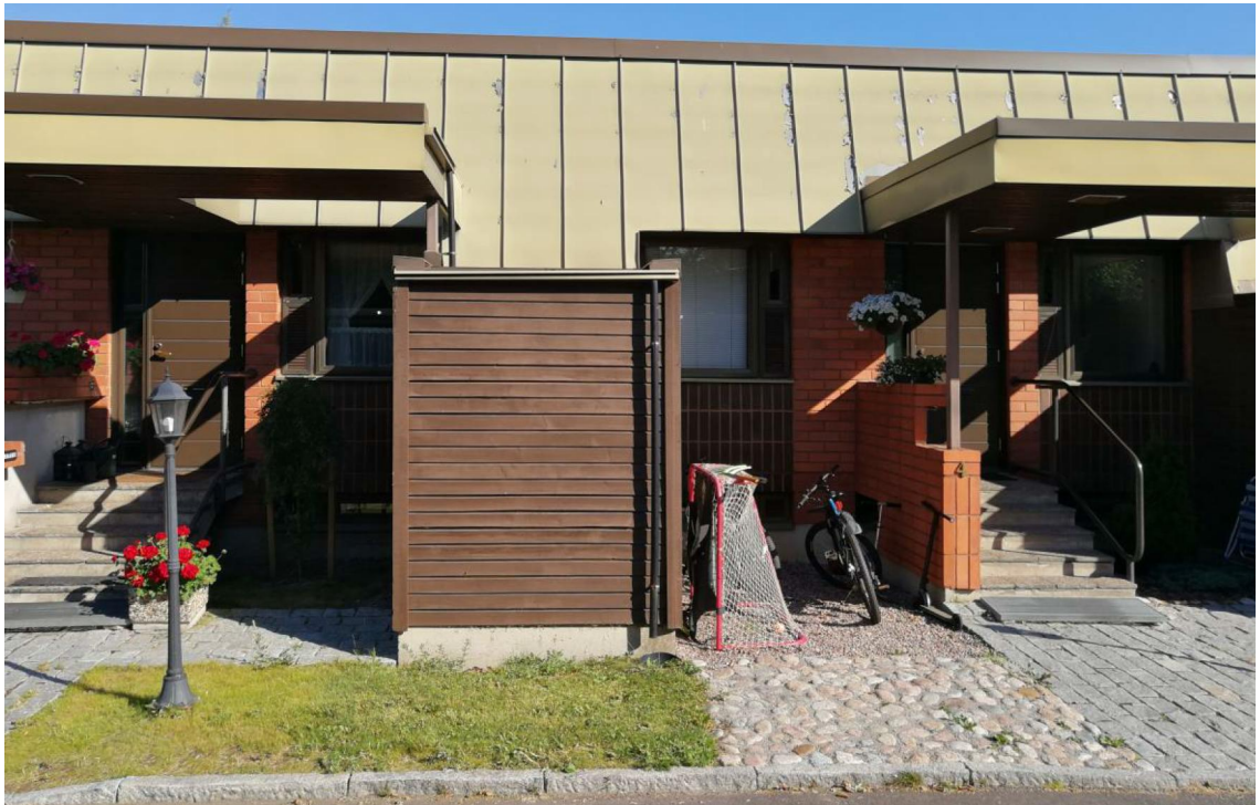
Kuva 38. Nykyisen valaisimen sijoitus sisäänkäynnin yhteydessä (Kuva: A-Insinöörit Suunnittelu Oy)
