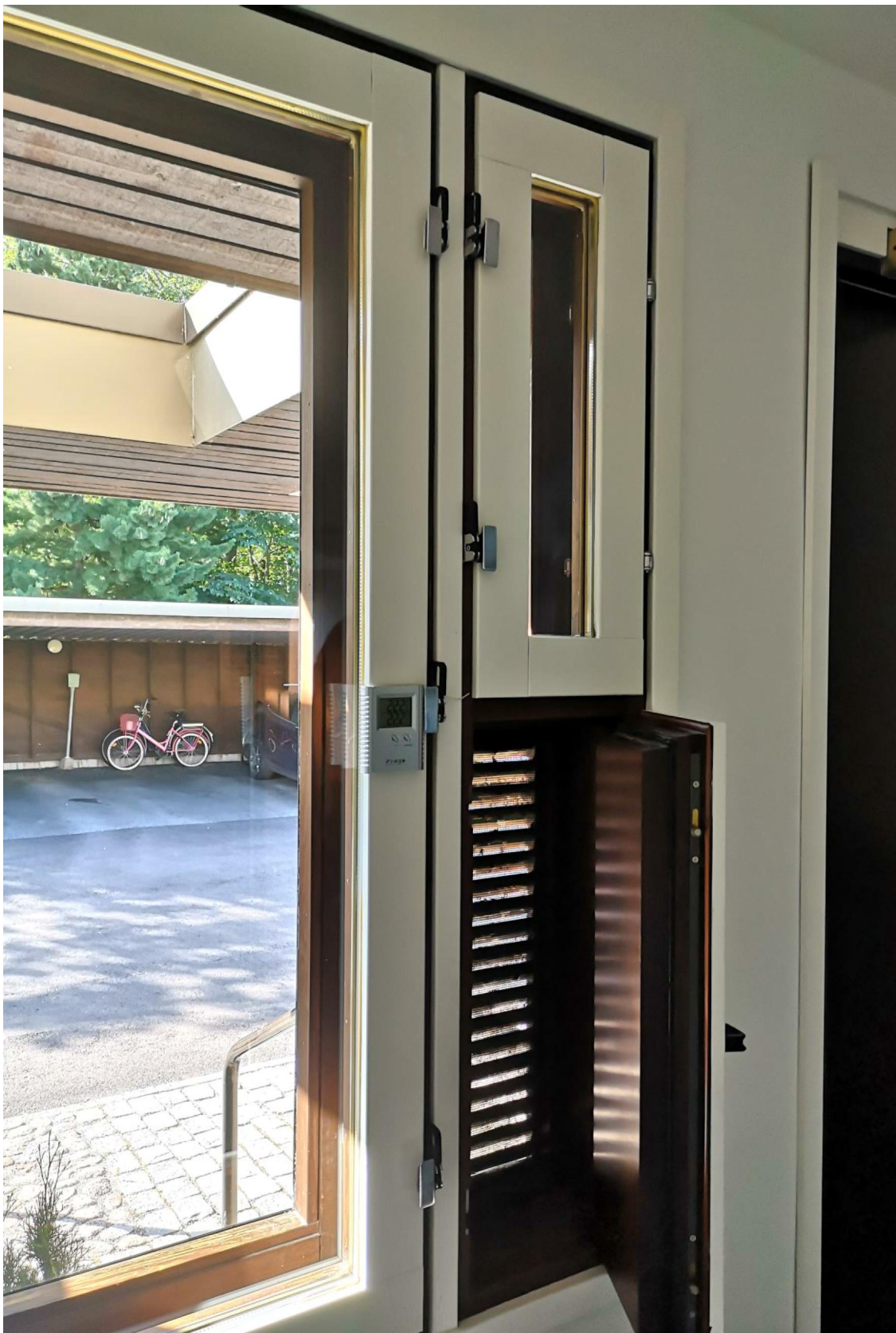
Kuva 41. Nykyiset eteläjulkisivun isot ikkunat (Kuva: A-Insinöörit Suunnittelu Oy)
