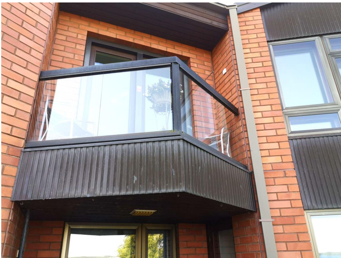
Kuva 6. Parveke pohjoispuolen pihasta katsottuna (Kuva: A-Insinöörit Suunnittelu Oy)
