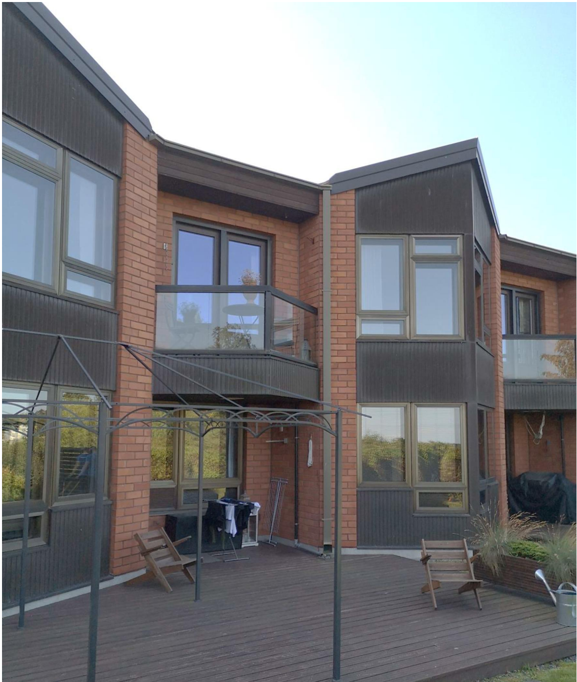
Kuva 2. Tiilipintaiset betonielementit ja kupariverhous (Kuva: A-Insinöörit Suunnittelu Oy)
