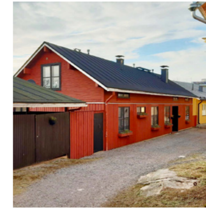
Kuva 2: Ilolankuja 4, Porvoo, 1973. Vanhassa Porvoossa sijaitseva rakennus mukaillee ympäristön pientä mittakaavaa ja julkisivuissa toistuu ympäristön värit ja materiaalit.
