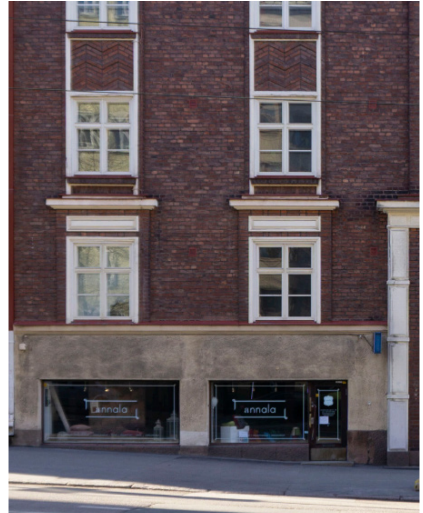
Kuva 11, Maantasokerroksen terastirappaus on sijoitettu materiaalin keston kannalta rasittavimmalle vöyhykkeelle. Onko tummuminen esteettisesti linjassa muun rakennuksen kanssa vai onko kyseessä suunnitteluvirhe? Runeberginkatu 54, Helsinki (Toivonen, 2019).
