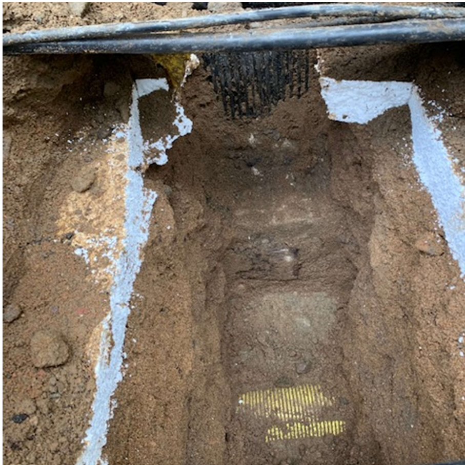
Kuva 13. Koekaivauksia rakennuksen vierustalla 25.9.2019.
