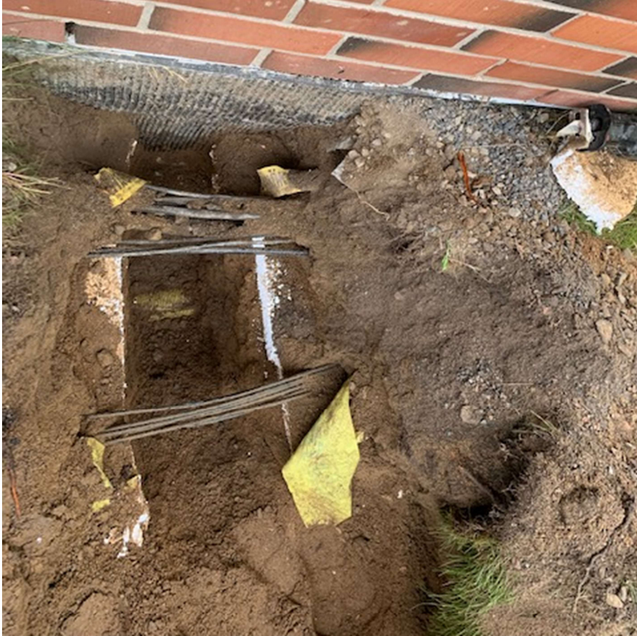
Kuva 12. Koekaivauksia rakennuksen vierustalla 25.9.2019.
