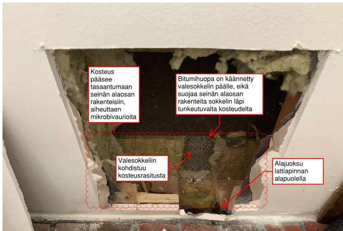
Kuva 19. Rakenneavaus sokkelirakenteeseen sisäkautta.
