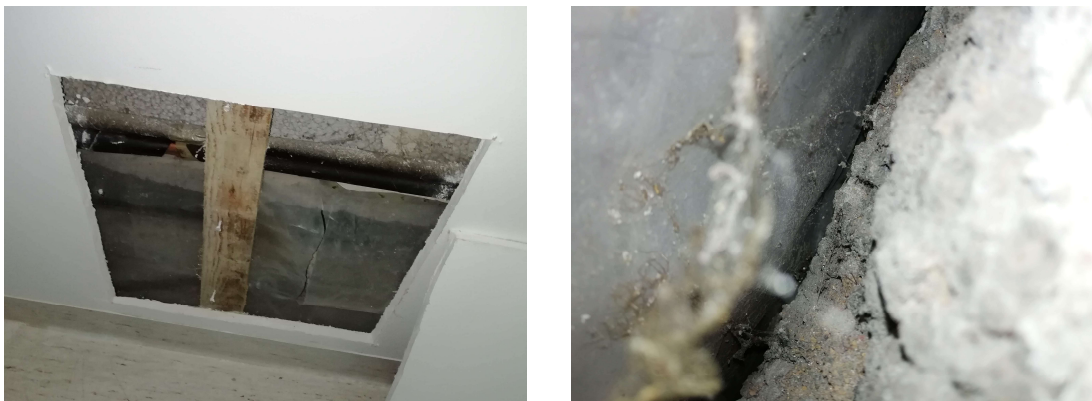
Kuva 17 ja 18. Rakenneavaus maanpaineisiin.
