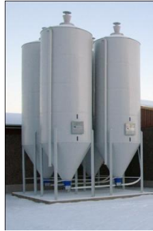
KUVA 12. Rehusiilo (Pelletin varastointi 2010).
