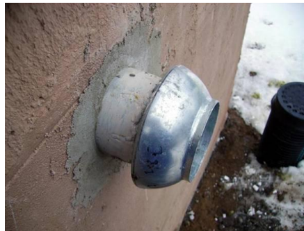
KUVA 15. Täyttöliitin pellettivarastoon (täyttöyhde) (Pelletin varastointi 2010).
