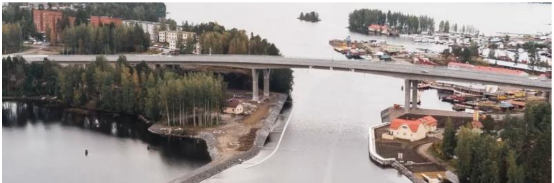
Kuva 8. Laitaatsalmen sillat (Väylävirasto 2019)
