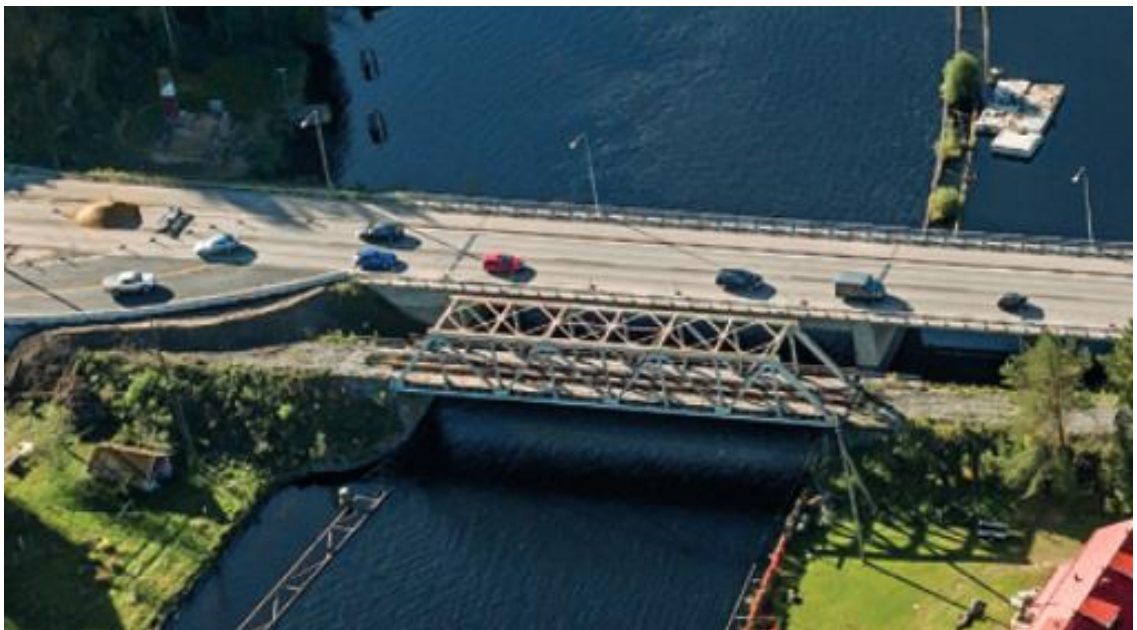
Kuva 11. Laitaatsalmen vanhat sillat (Väylävirasto 2019)
