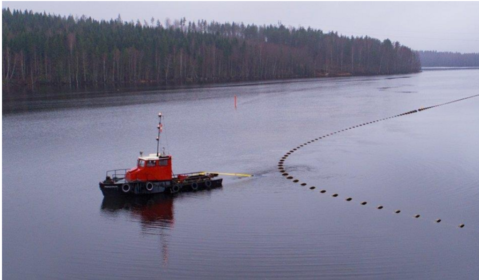
Kuva 5. Putki vedetään lautalla oikeaan sijaintiin (VMSV 2019).
