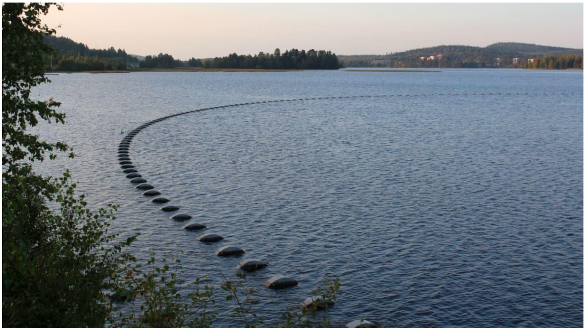
Kuva 1. Vesistöön asennettava paineviemäri vedenpinnalla (Yle 2019).
