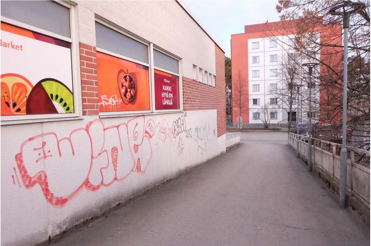
KUVA 7. Käynti pistetaloille keskuskujalta (Pussinen 2020-04-26)
