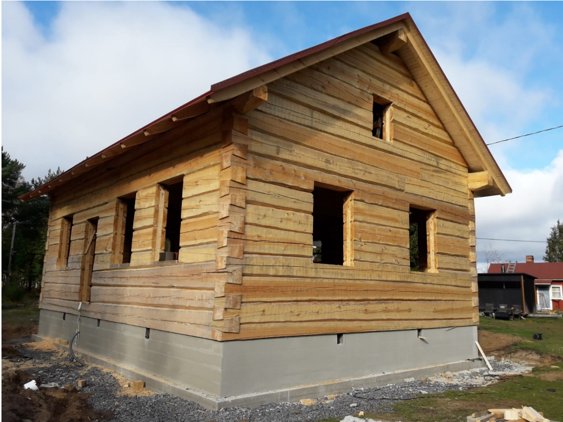
KUVA 25. Referenssikohde Kaitala juuri pystytettynä ja katettuna
