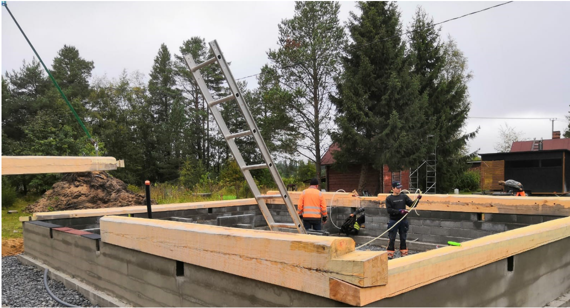
KUVA 26. Ensimmäisen hirsikerran asennus bitumikaistan päälle
