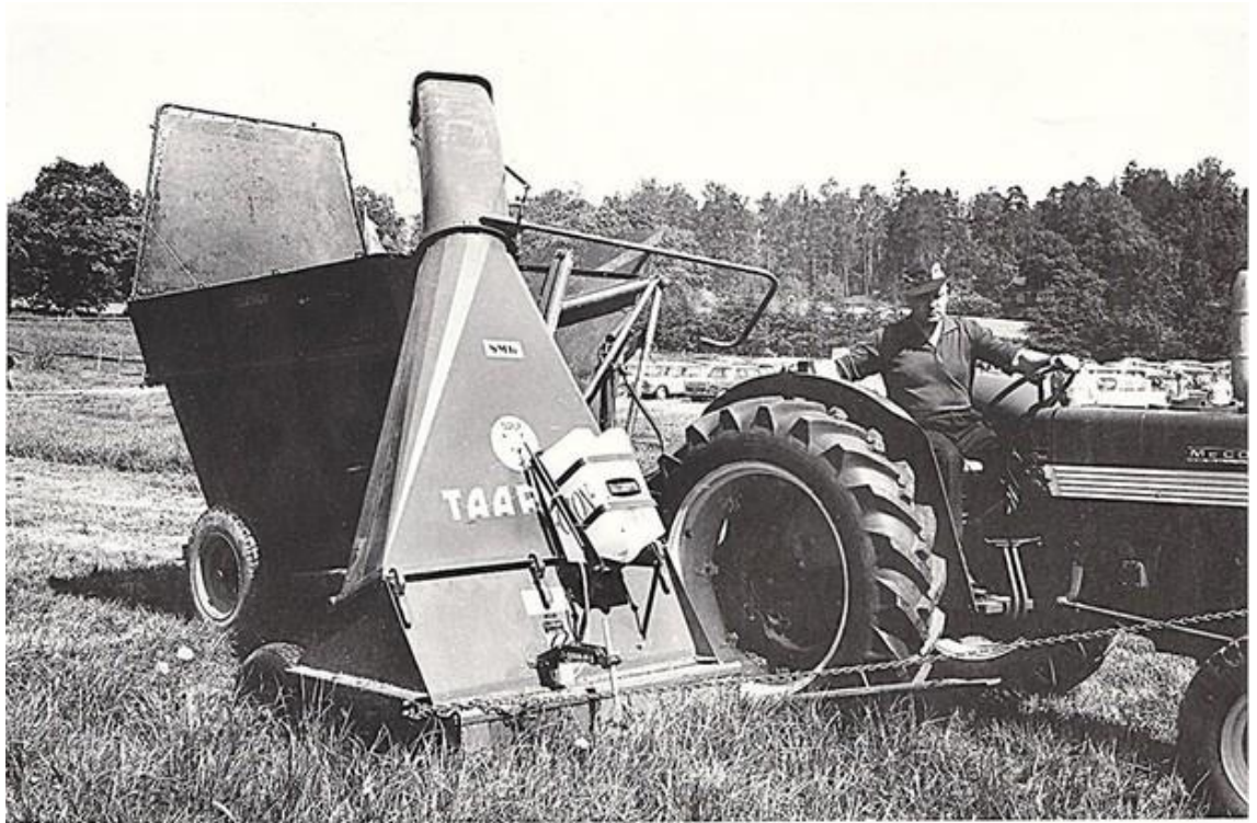
Kuva 7. Kelasilppurit ovat olleet osa rehunkorjuuketjua jo 1950-luvulta lähtien. Ennen niittosilppuria, säilöntäaineena toiminut AIV-liuos levitettiin yleensä rehun säilöntäpaikalla, mutta kelasilppuri mahdollisti liuoksen lisäämisen jo niittovaiheessa. (Koneviesti 2019)
