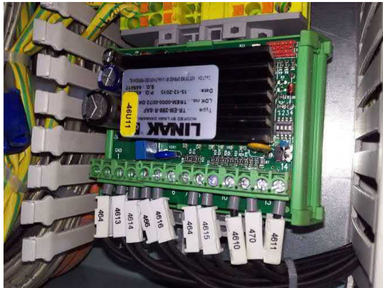
Kuva 9. TR-EM-288-SAF -asennoin ohjauspaneeliin asennettuna. (Alfa Laval Aalborg Oy:n sisäinen tietokanta 2020)
