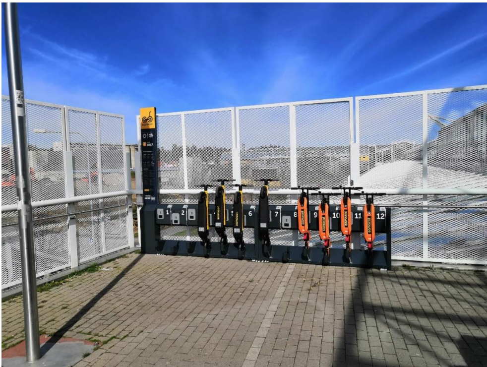
Bild 1. En laddningsstation för Samocat elsparkbrädor i Nordsjö. (HSL 2019)
