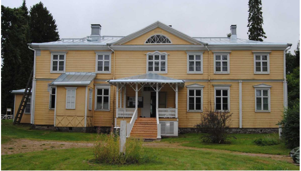
Kuva 3. Urjärvenkartanon sisäpihan puoleinen julkisivu.
