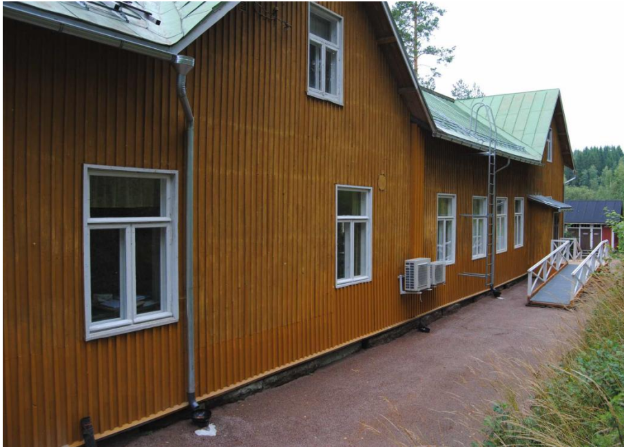
Kuva 1. Verlan seurantaloon takajulkisivu.
