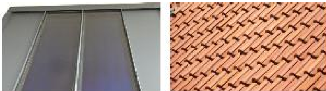
Kuva 8. Katemateriaaleja. Saumapeltikatto, johon on integroitu aurinkokeräimet ja tiilikatto. (Kuvat: pxhere.com)
