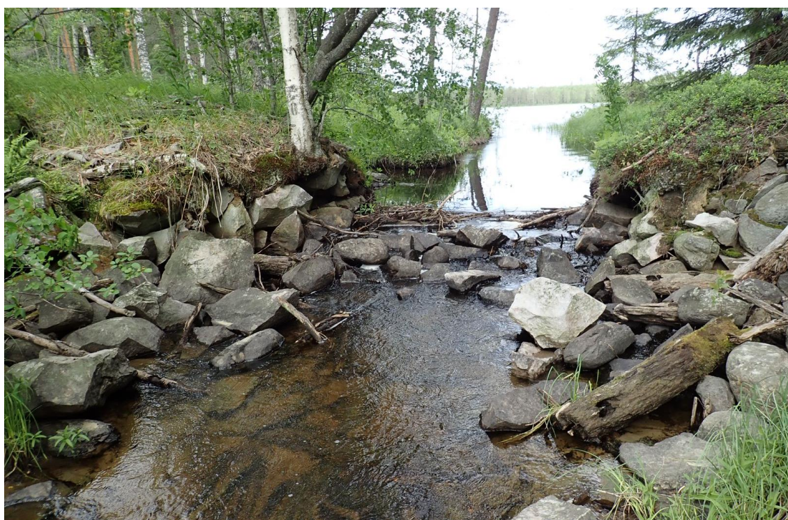
Kuva 34. Ripulinjärven pohjapato voi muodostaa kulkua haittaavan esteen kaloille (Kuva: Jukka Oinonen).
