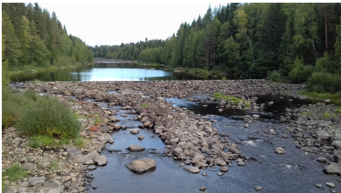
Kuva 40. Lieksanjoen vanhaan uomaan on rakennettu vuonna 2004 viisi maise-mointipatoa, joiden yhteydessä on luonnonmukaiset kalatiet (Turunen 2016) (Kuva: Henri Heiskanen).
