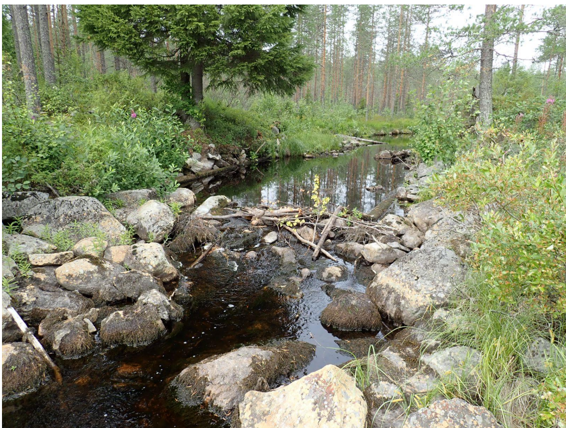
Kuva 26. Paasijärven padon tilalle on rakennettu kivinen pohjapato (Kuva: Jukka Oinonen).
