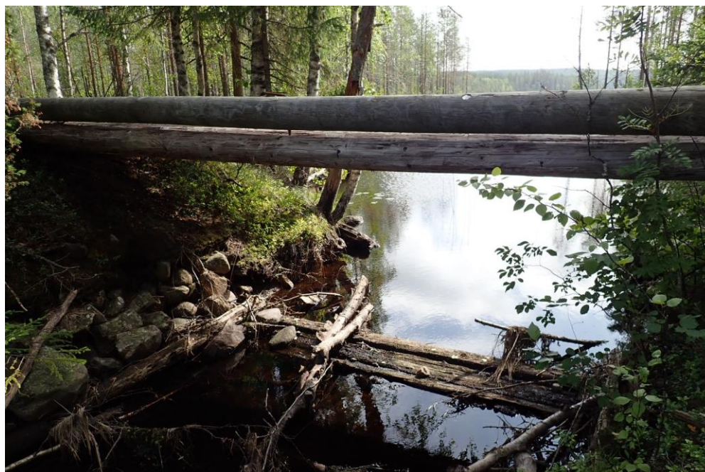
Kuva 25. Kujankijärven pato on korvattu puisella pohjapadolla, joka voi estää kalojen ohivaelluksen vähän veden aikaan (Kuva: Jukka Oinonen).
