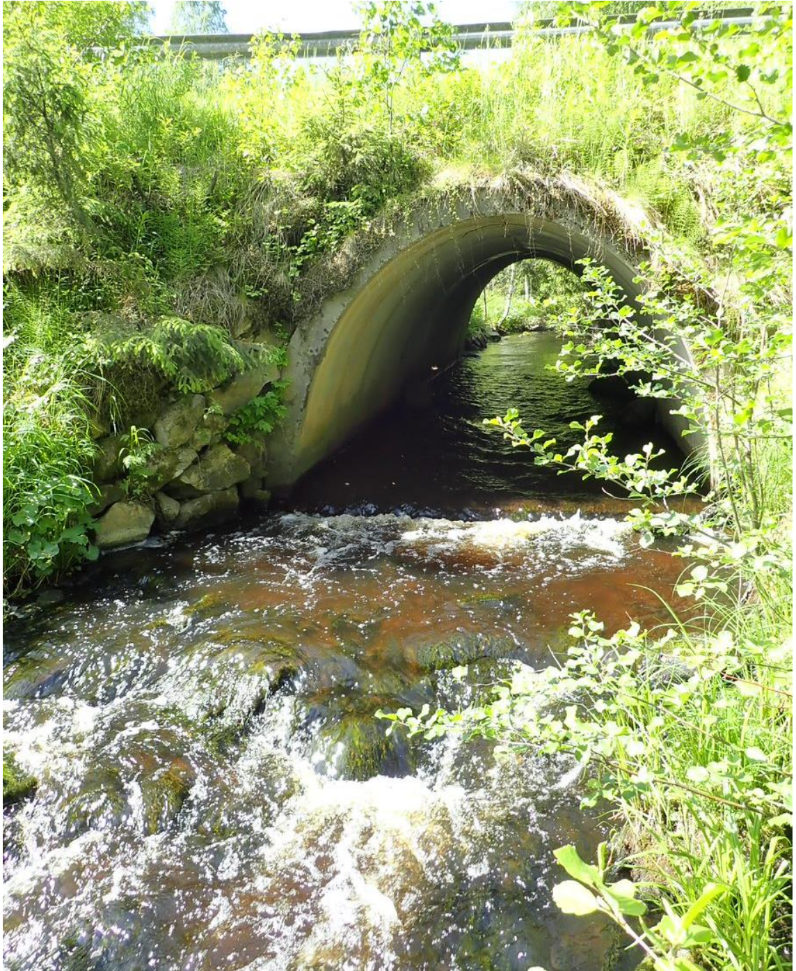
Kuva 21. Siltapuro 2 on betonirakenteinen putkisilta. Rakenteen voidaan katsoa muodostavan vaellusesteen kaloille ainakin alivirtaamatilanteissa (Kuva: Jukka Oinonen).
