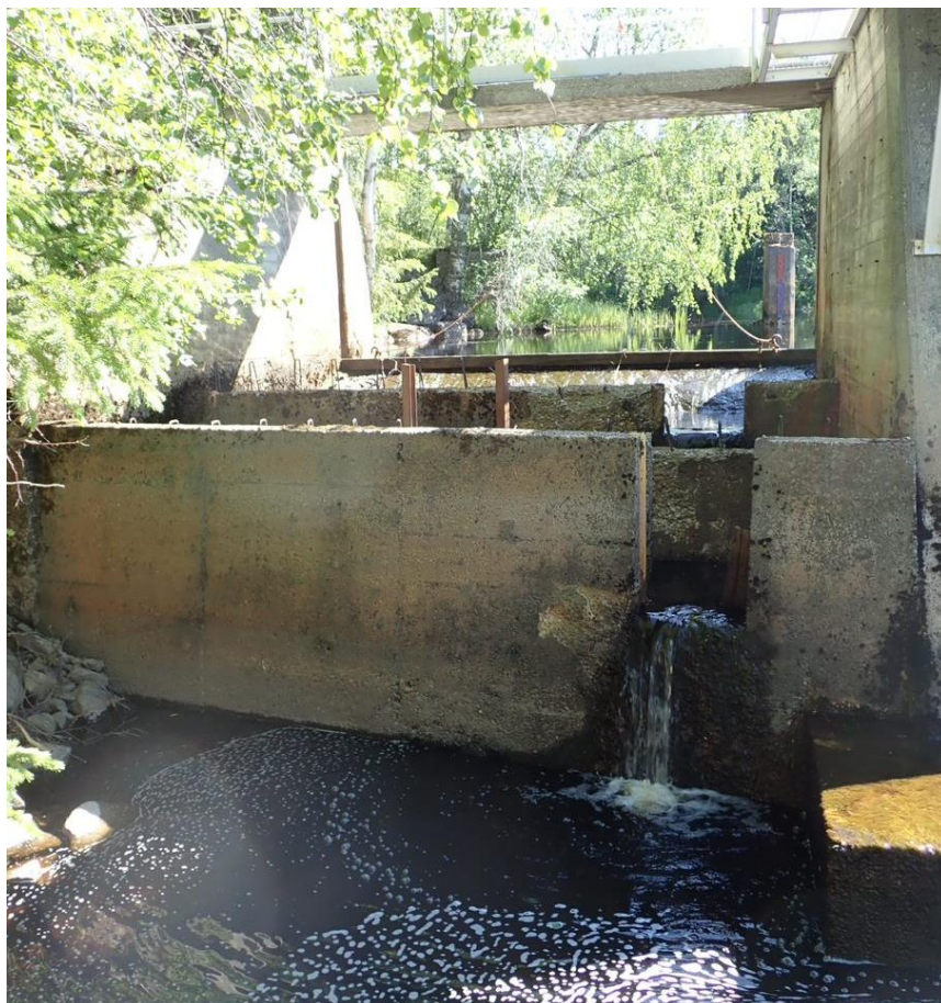
Kuva 17. Kalaporras muodosti 26.6.2019 vaellusesteen kaloille (Kuva: Jukka Oinonen).
