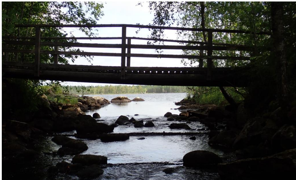
Kuva 24. Talasjärven pato on korvattu puisella pohjapadolla (Kuva: Jukka Oinonen).
