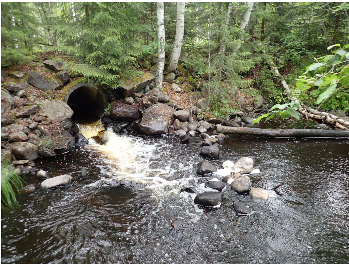
Kuva 30. Koskelan myllypaikan patopenkkaan asennettu betonirumpu aiheuttaa vaellusesteen Venejoessa (Kuva: Jukka Oinonen).
