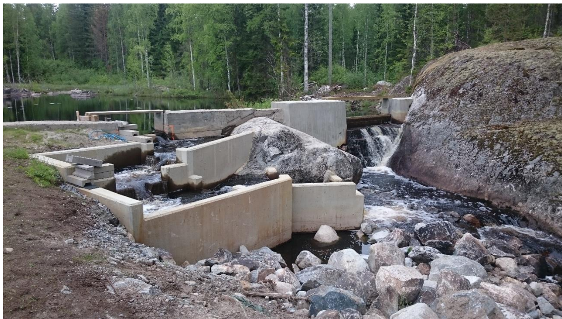
Kuva 41. Lieksan Saarijokeen vuonna 2017 rakennetut kalaportaat mahdollistavat kalan kulun vanhan myllypadon ohi (Kuva: Jukka Oinonen).
