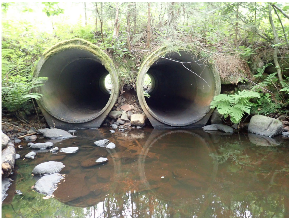
Kuva 35. Teerijärvestä Kiskonjokeen laskevan Teeripuron betonirummut olivat 29.7.2019 kuivillaan muodostaen vaellusesteen kaloille (Kuva: Jukka Oinonen).
