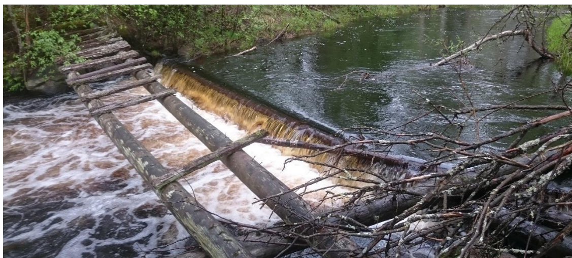
Kuva 37. Kansalan myllypaddon jäänteet vaikeuttivat Rauanjoella harjoitettua melontaa ja kalan kulkua (Kuva: Jukka Oinonen).
