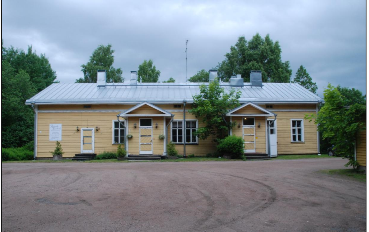
Kuva 8 Etelän puoleinen julkisivu.
