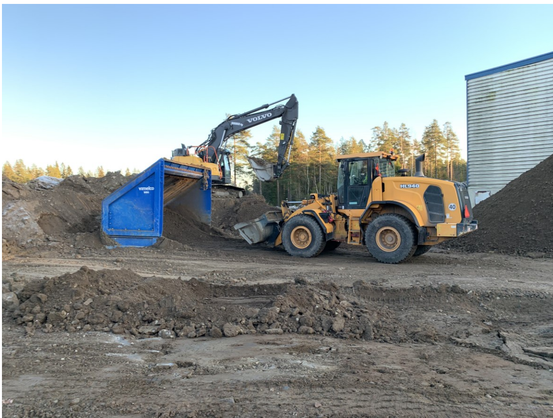
KUVA 2. Kaanaan Kaivimen työmaa Kangasalla. Välppäyksellä erotellaan maa-aineet toisistaan.
