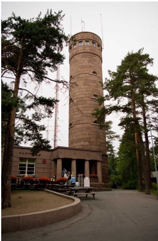
KUVA 1. 1920-luvulla Suomen Graniitti Oy, jäljempänä Tampereen Kovakiven toimittamat kivet Pyynikin näkötorniin. Kivi: Vehmaan punainen graniitti (Tampereen Kovakivi Oy)
