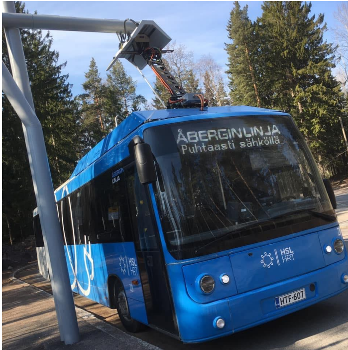
Kuva 5. Kaupunkiliikenteen sähköbussi lataamassa akkuja Espoossa (Kuva: Selin, S.)
