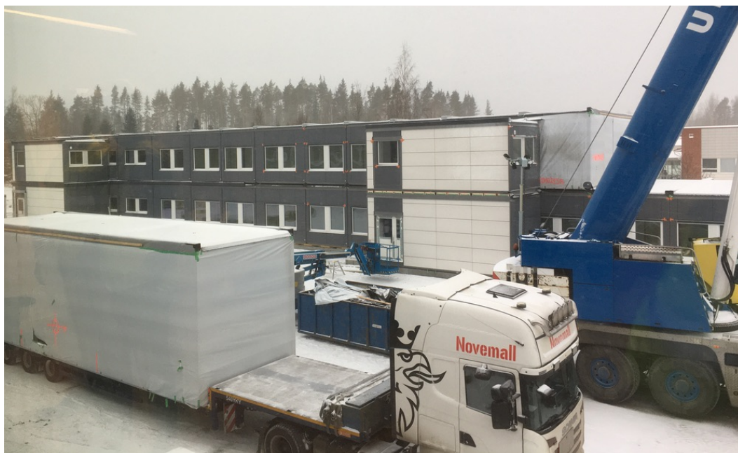
KUVA 2. Adapteo Oyj:n työmaavierailu (Keskinen, helmikuu 2019)
