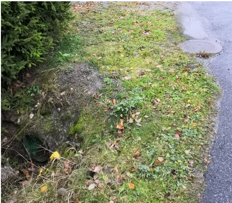
KUVA 12. Lähtötietoihin verrataan maastossa olevia kaivoja ja rumpuja
