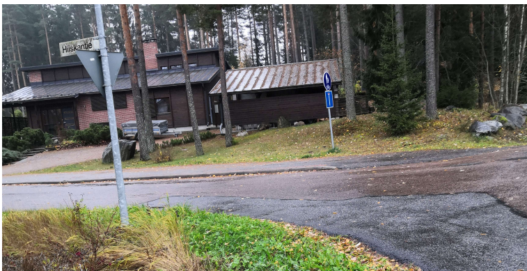
KUVA 13. Hiiskantiellä sijaitseva kvl, johon suunniteltava kvl liittyy
