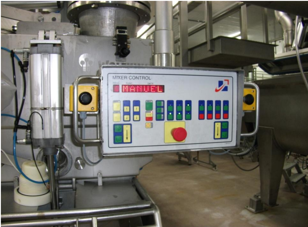
Bild på gamla panelen.
