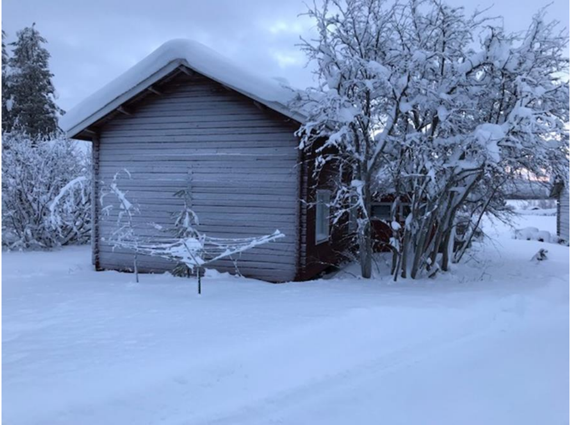
Kuva 4. Hirsinurkat näkyvillä talon toisessa päässä. Nurkat tulee lyhentää uuden eristyskerroksen asentamista varten.
