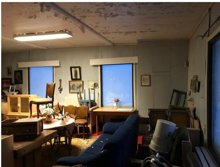
Kuva 1. Sisäpinnat ennen korjaustöiden aloittamista
