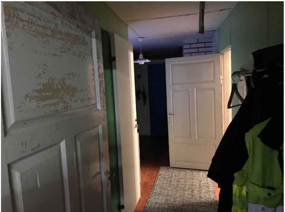
Kuva 5. Uuden WC-tilan ovi on kuvan otto paikan kohdalla. Nykyinen WC on heti vasemmalla sijaitsevassa huoneessa.
