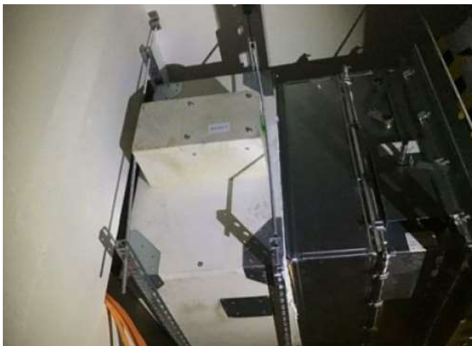
Kuva 19. SEDM, keskeneräinen asennus
