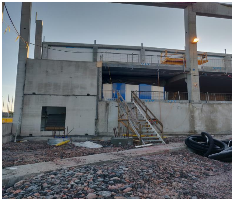
Kuva 18. Energiamoduuli nostettuna lopulliselle paikalleen.
