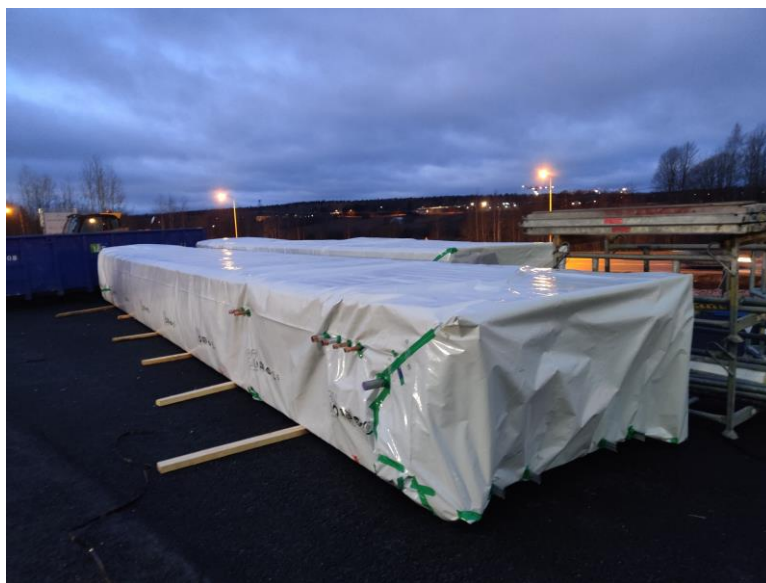
Kuva 11. Sääsuojatut tate-käytäväelementit ulkopihalla
