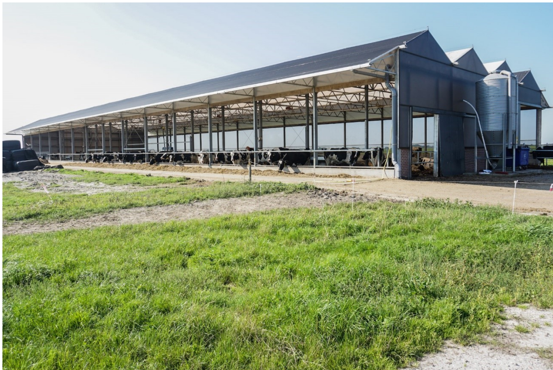
Kuva 10. Suurimmassa osassa Hollannin kuivikepohjapihatissa navetan runkona toimi kasvihuone, jolla saatiin navettaan paljon ilmaa ja valoa, sekä myös rakentamiskustannus oli perinteistä navettarakennusta edullisempi.
