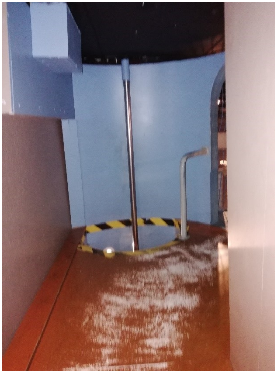
KUVA 38. Aukko ja tanko
