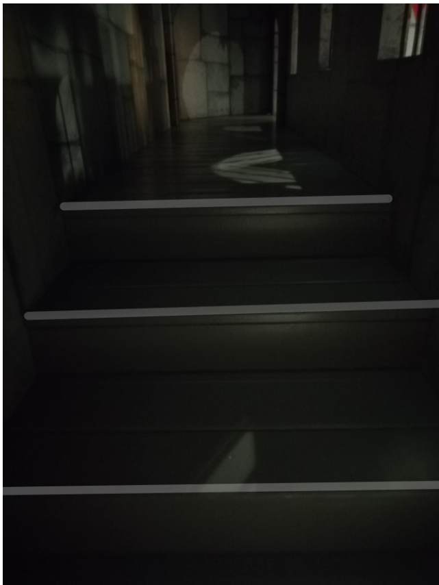
KUVA 24. Kontrastiraidat tunnelin portaissa
