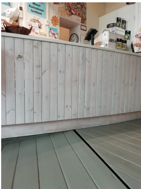
KUVA 15. Esimerkki kontrastiraidan vaikutuksesta luiskan havaittavuuteen
