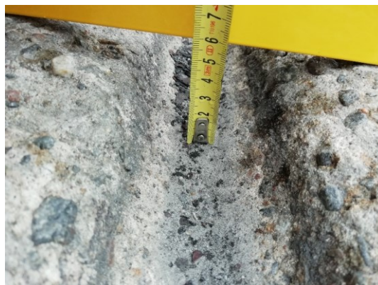
KUVA 4. Sadevesikouru kulkuväylällä KUVA 5. Sadevesikourun syvyys
