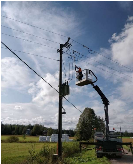
KUVA 2. Sauvamenetelmällä tehtävä sähköjen palautus nostokorista (Ståhl 2019)
