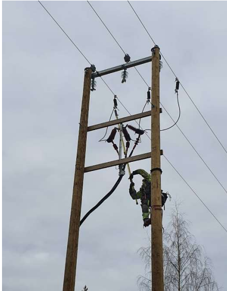
KUVA 6. Jomppien kiinnittäminen apukannattimiin jännitetyösauvalla (Ståhl 2019)
