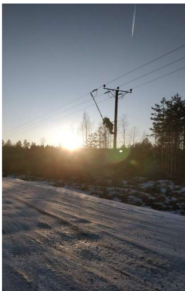
KUVA 3. Sauvamenetelmällä tehty sähköjen palautus pylvästä (Ståhl 2019)
