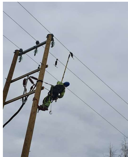
KUVA 5. Apukannattimien asennus (Ståhl 2019)
