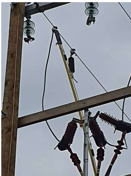
KUVA 7. Jomppien kytkentä linjaan jännitetyösauvalla (Ståhl 2019)
