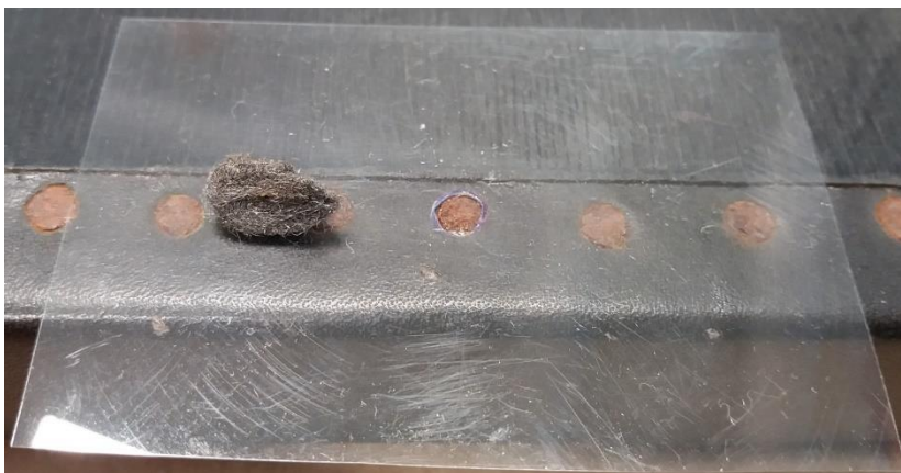
Kuva 41. Naulan kannan puhdistus teräsvillalla
