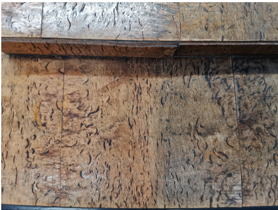
Kuva 28. Vasemmalla kannen puhdistettu pinta ja oikealla puhdistamaton pinta.
