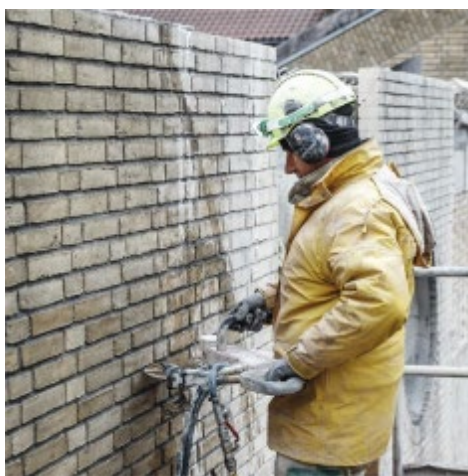
Kuva 10. Tiilipalojen leikkaus käsikäyttöisellä timanttisahalla Tanskassa. (Vanhat tiilijulkisivut moduuleina uuteen taloon 2018, 30)
