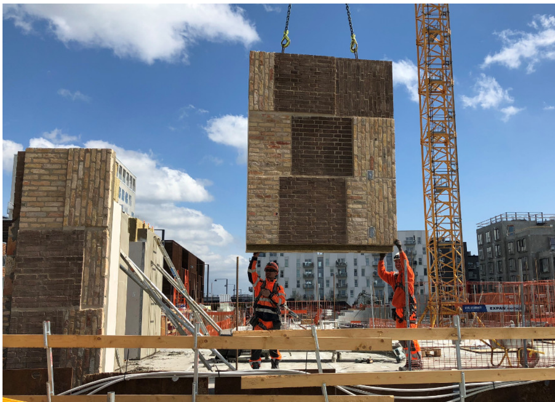
Kuva 13. Tiilibetonelementin nostaminen ja asentaminen Tanskassa. (Stort og ekte gjenbruksprosjekt 2018)
