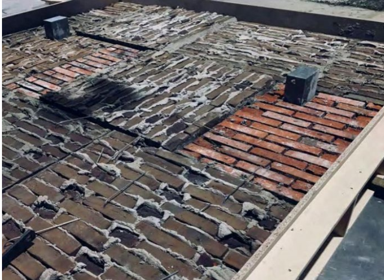
Kuva 11. Kierrätetyn tiilibetonelementin valmistaminen. (Gustafsson 2019, 15)
