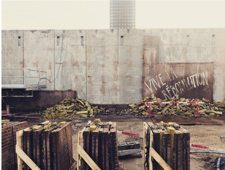
Kuva 2. Tiilipaloja irrotettuna ja odottamassa pois kuljetusta Tanskassa. (Lendager 2018)
