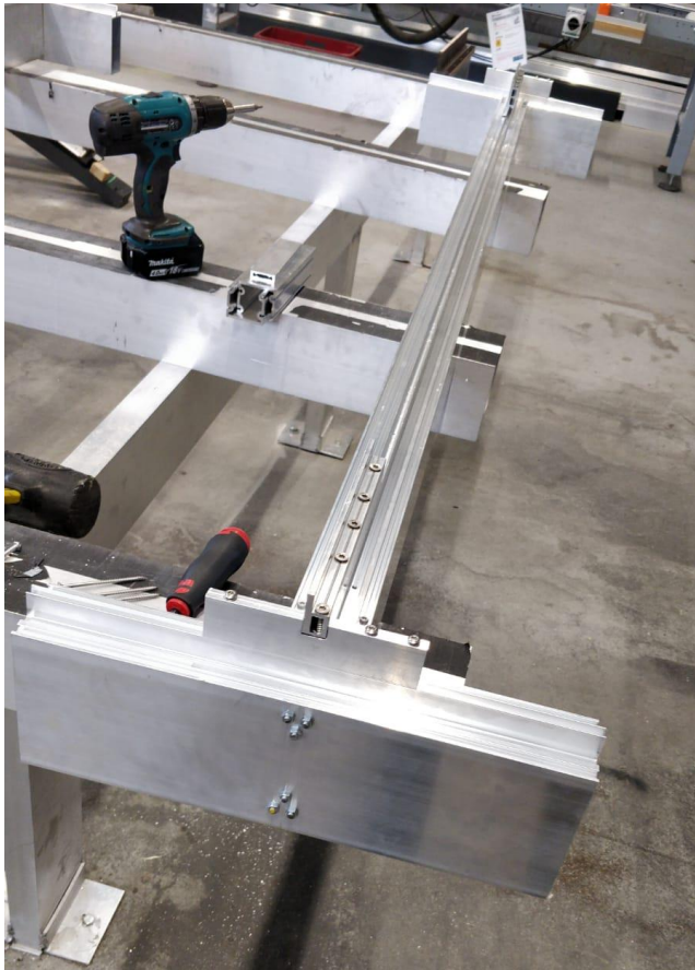
KUVA 14. Prototyyppien rakennusta protopajalla
