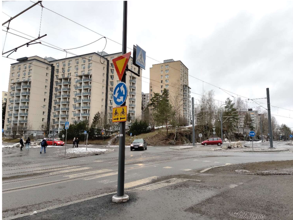
Kuva 31. Pitkähkő suojatie sekaliikennekaistojen yli, osittain kuluneet merkinnät, suojatienmerkki ei näy Insinöörinkatua ajavalle ajoneuvoille. Opiskelijankadun kiertoliittymä, kuvattu luoteeseen päin.
