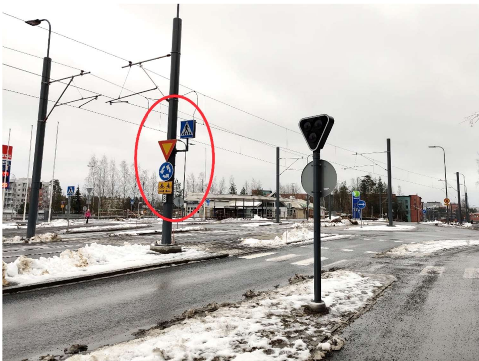
Kuva 27. Orivedenkadun kiertoliittymän liikennemerkit on sijoitettu vain ajoradan vasemmalle puolelle pohjoisesta Insinöörikatua pitkin saavuttaessa.
