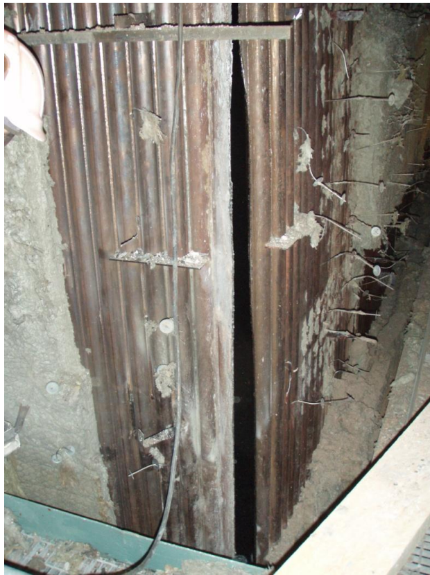
Kuva 10. Rakenteellinen suojaus eli ns. heikko nurkka, joka suuntaa räjähdysvoiman haluttuun suuntaan (kuva J. Mäkelä).
