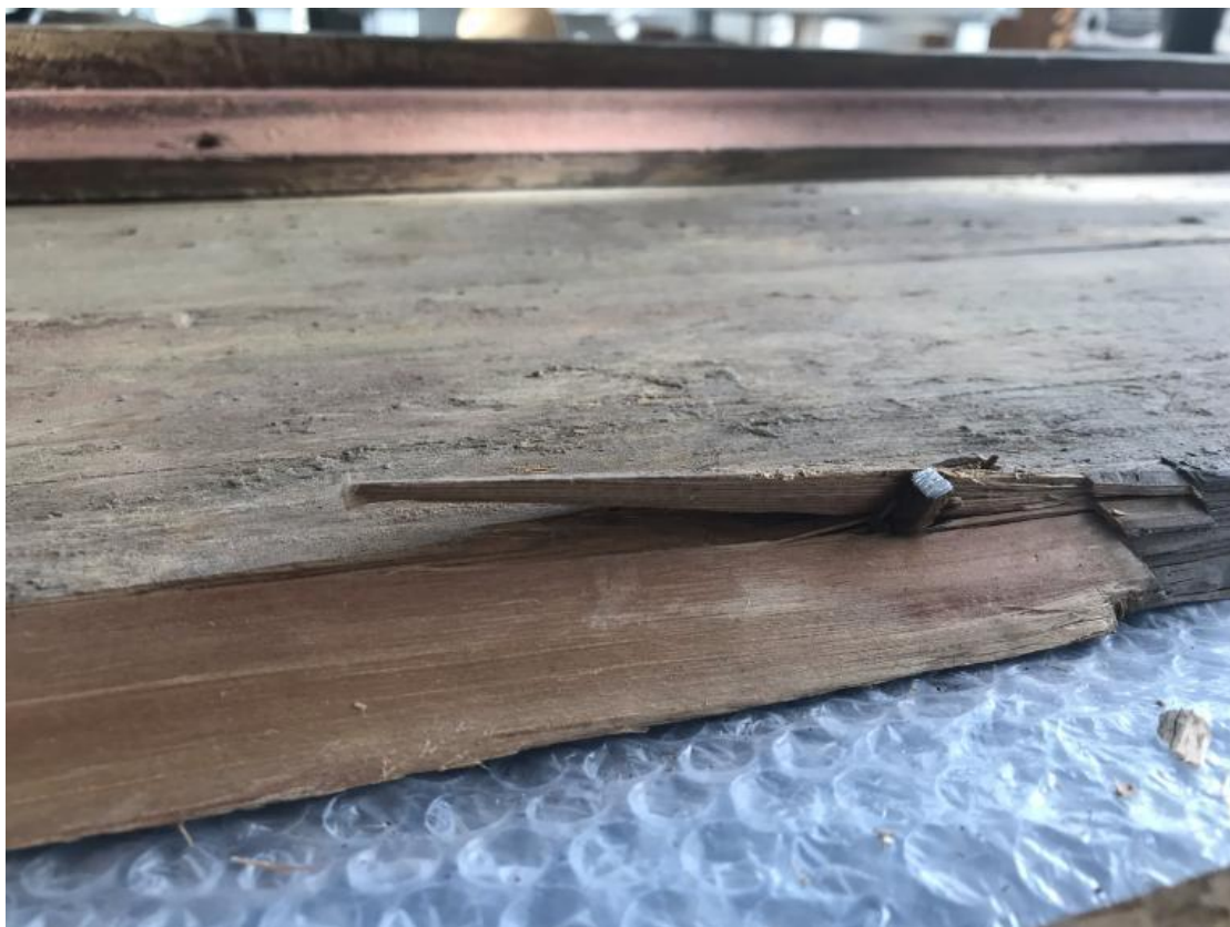
Kuva 10. Esimerkki siitä, miten iso naula on halkaissut puuta. (Pihlainen 2020)
