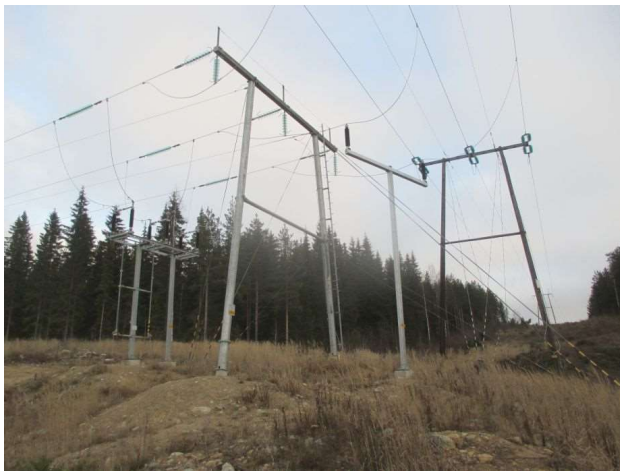
Kuva 6. Johtohaaralla sijaitseva korpierotin (Kärnä, 2019)
