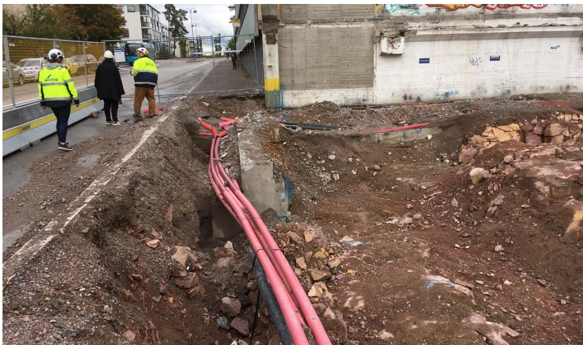
KUVA 1. Maan alta voi tulla vastaan yllätyksiä toteutusvaiheessa.
