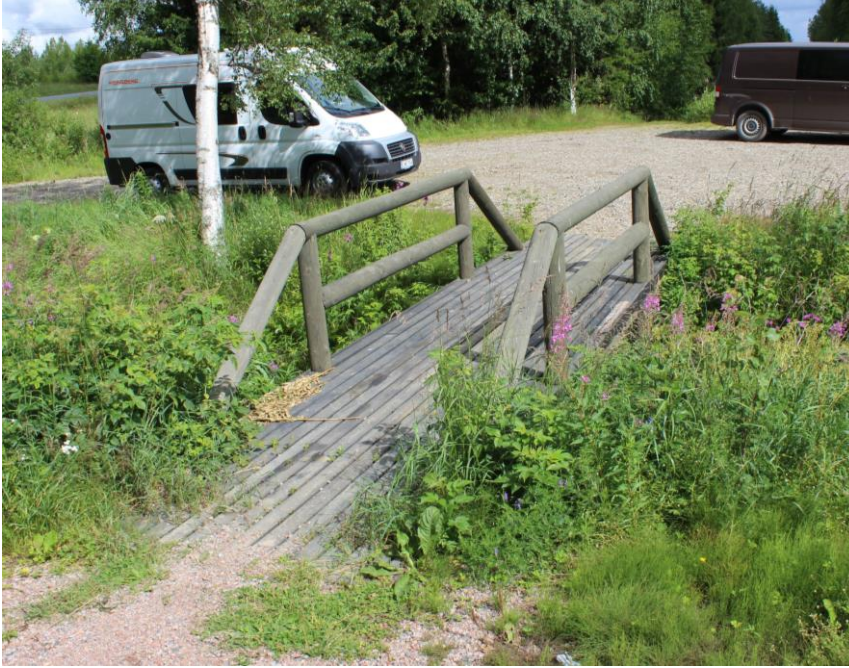
KUVIO 7. Pikku-Vatjusjärven uimarannan tukialueen ja parkkipaikan välinen silta Kuva: Tuomas Rantasuomela
