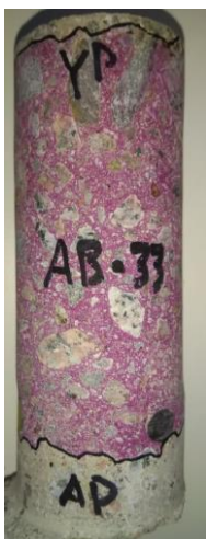
Kuva 1. Parvekelaatasta porattu betoninäyte, jossa voidaan havaita pitkälle edennyt alapinnan karbonatisoituminen värjäntymättömänä vyöhykkeenä.
