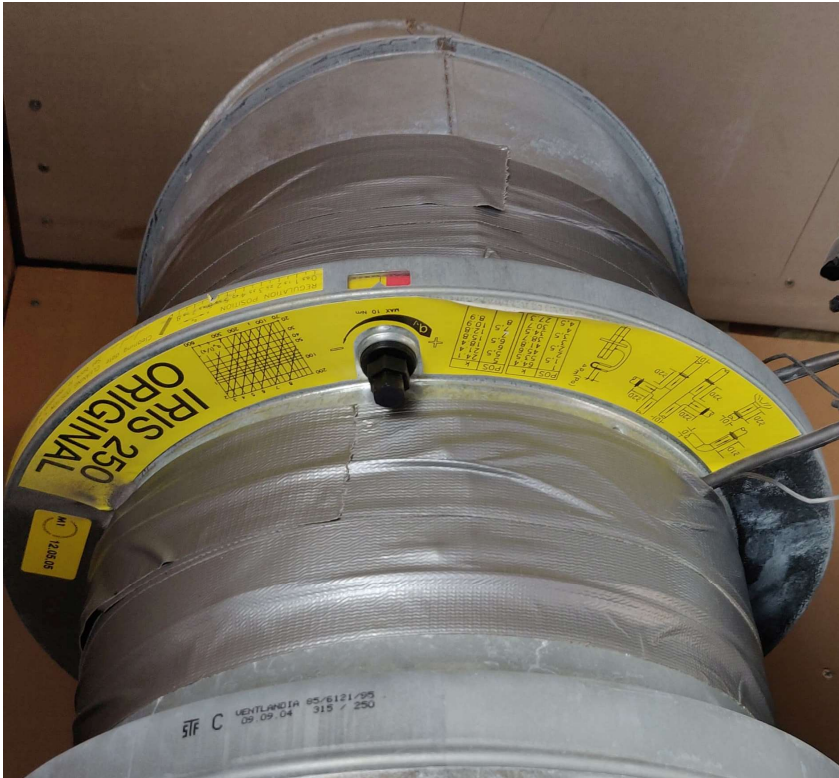
KUVA 13 Jäteilmakanavan IRIS 250 -virtaussäädin
