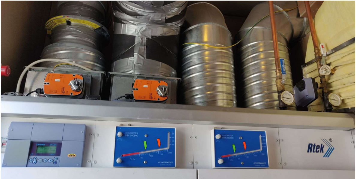
KUVA 19 Ilmanvaihtokoneen kanavalähdöt
