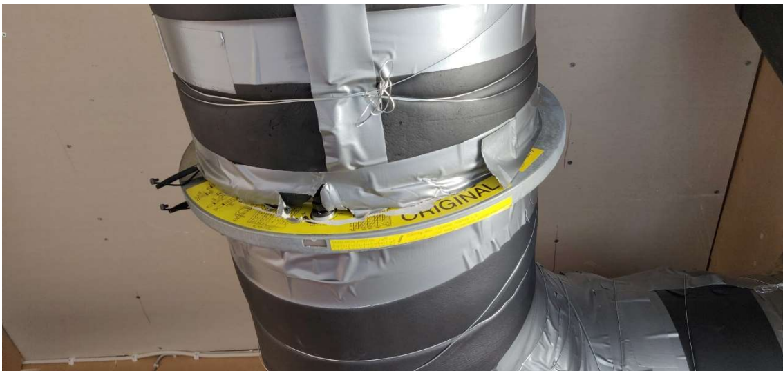
KUVA 14 Raitisilmakanavan IRIS 315 -virtaussäädin
