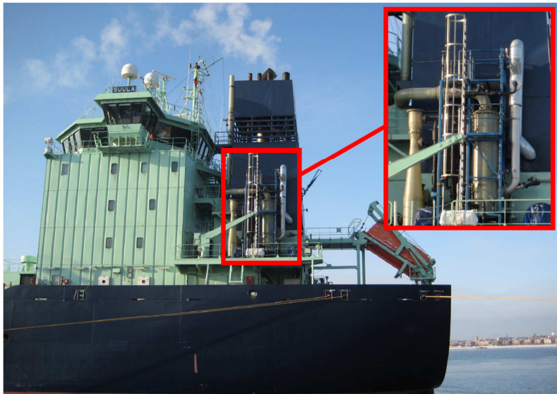
Figure 5 Wärtsilä Scrubber System onboard MT Suula
