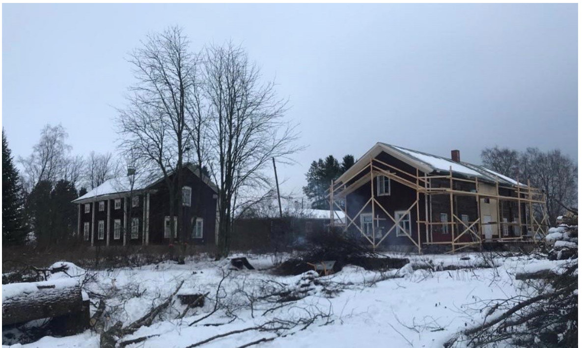
Kuva 56. Viereisen kiinteistön julkisivun vertailua joelta päin.
