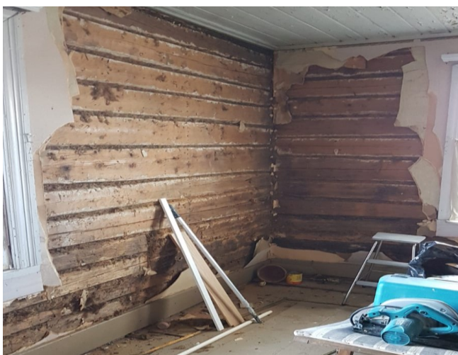
Kuva 81. Sisätyöt alkoivat materiaalien purkamisella.
