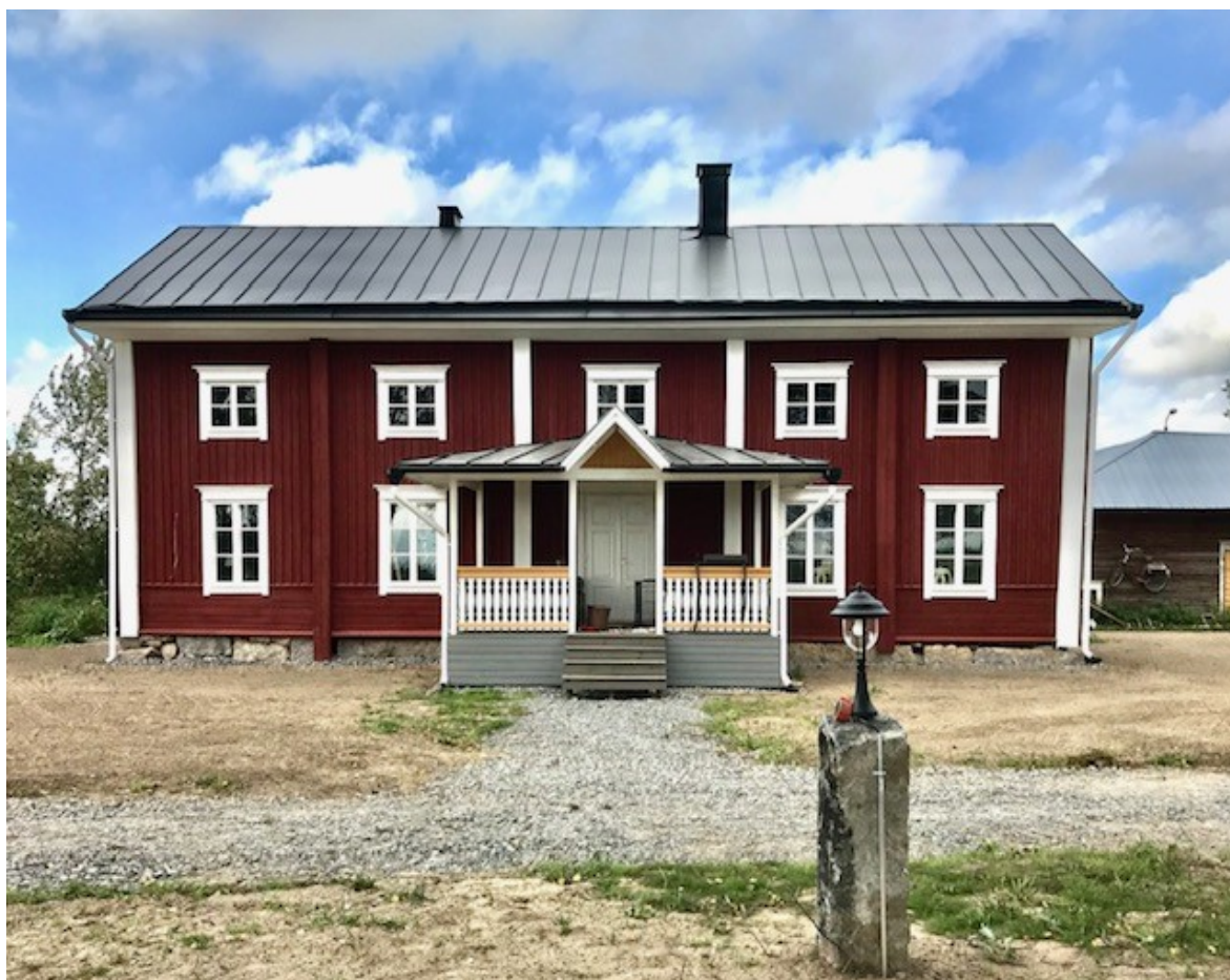
Kuva 102. Korjaukset valmiina 1. vaiheen jälkeen, julkisivu etelään.
