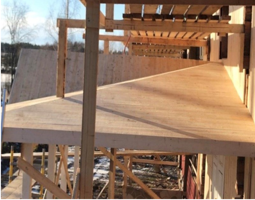
Kuva 74. Uuden kuistin katto rakentuu.
