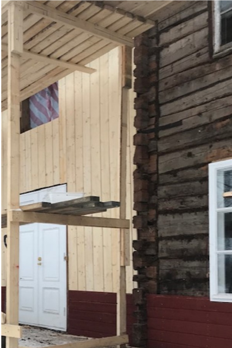
Kuva 58. Uusi eteläseinän laudoitus rakentuu eri levyisistä laudoista.
