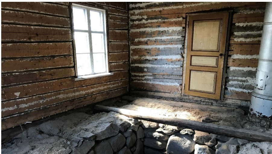
Kuva 41. Kamarin purettu lattia, sekä niskat. Kuvassa etelän puolen kamari, jossa. näkyy sisäpuoleisen oven ootraus.
