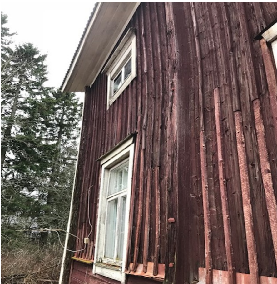
Kuva 24. Uusittava täkkihirsi eteläseinustalla.
