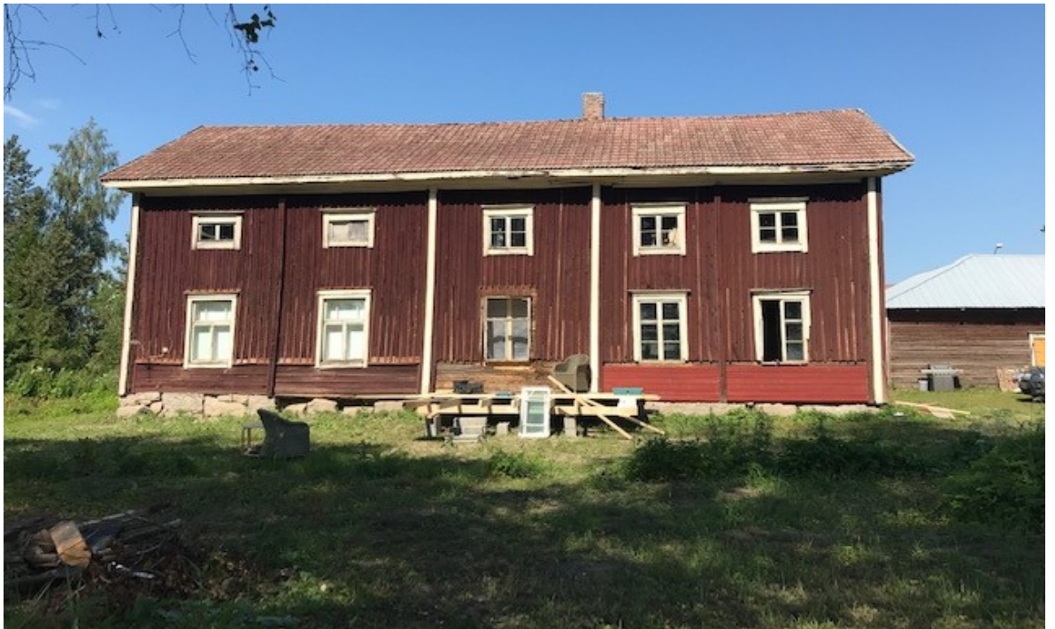
Kuva 43. Rakennuksen vierustat raivattuna.
