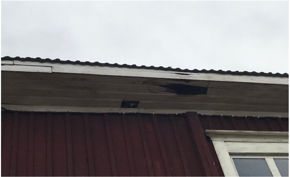
Kuva 37. Räystäään alalaudoitusta pitkällä sivulla.
