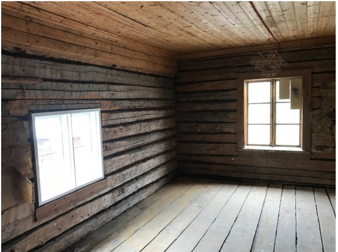
Kuva 94. Kesäsali saneerattujen kamareiden yläpuolella. Ikkunat ovat pitkällä sivulla 4-ruutuiset ja päädyssä 6-ruutuiset. Päädyn ikkunat ovat vielä uusimatta. Korkeiden ikkunoiden väliin jätetään seinien tuulivuoraukseen aikoinaan käytettyjä sanomalehtiä ja ne suojataan.
