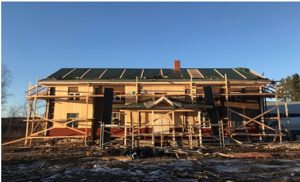
Kuva 57. Ensimmäiseksi laudoitettiin keskiosa, jotta uuden kuistin kattorakenteet saatiin tehtyä yhtenäistä pintaa myöden.
