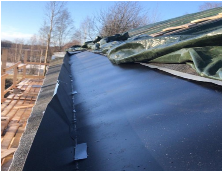
Kuva 69. Jalkaränni rakentuu osaksi kattoa.
