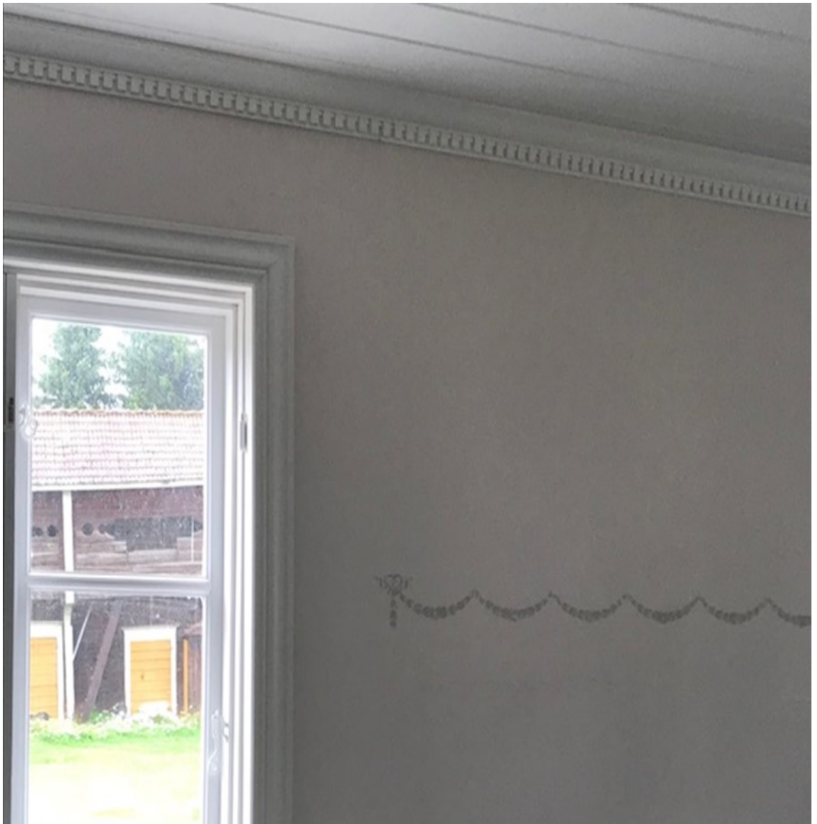
Kuva 87. Pohjoisen puolen kamariin valittu sävy on lämpimämpi ja sinne maalattiin nauhakuviot sablonilla.
