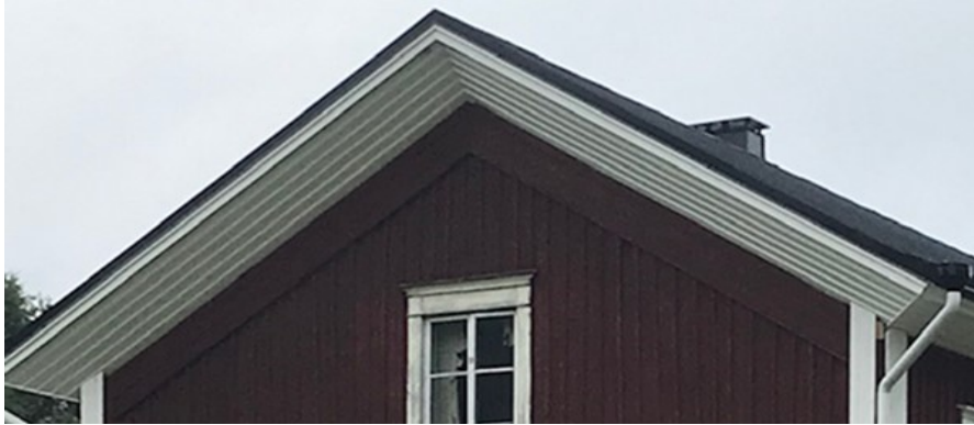
Kuva 70. Uusittu räystäään laudoitus.
