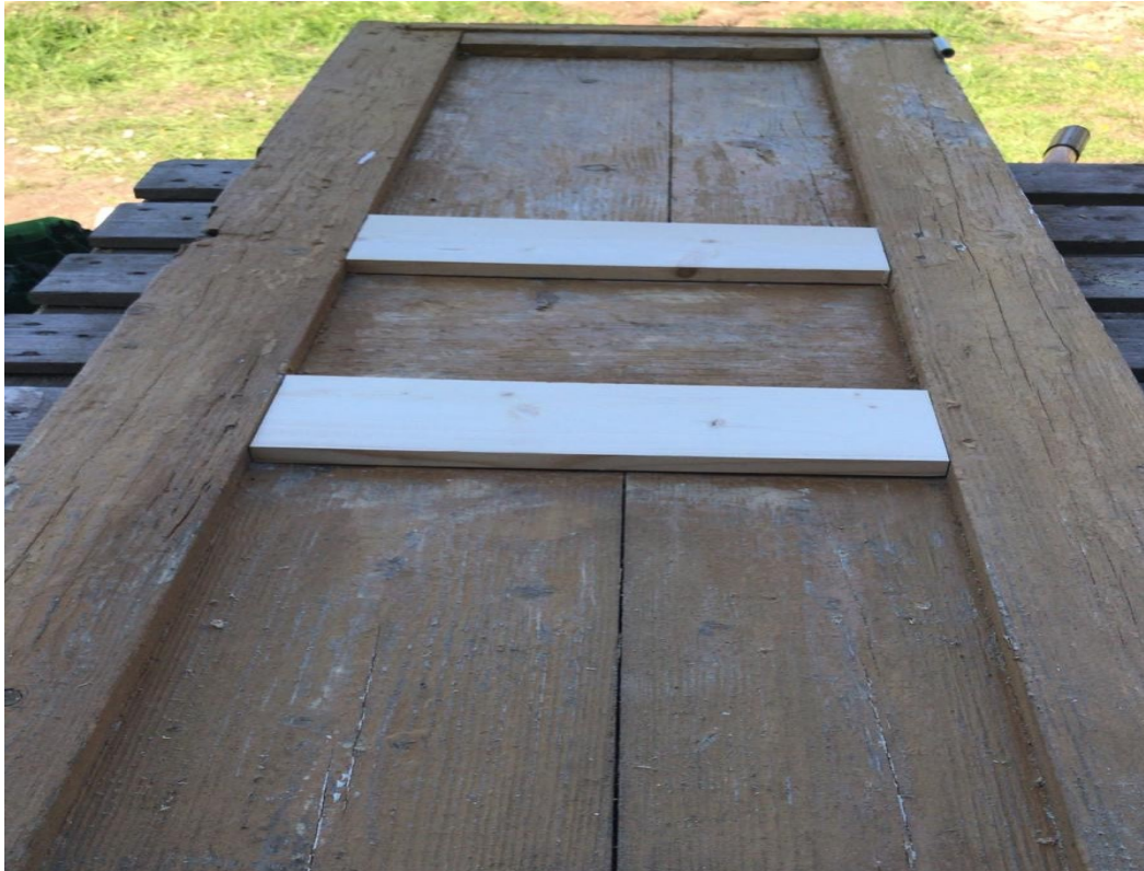
Kuva 34. Vanhat ulko-ovet jouduttiin korjaamaan osittain, että rakenne säilyy ehjänä.
