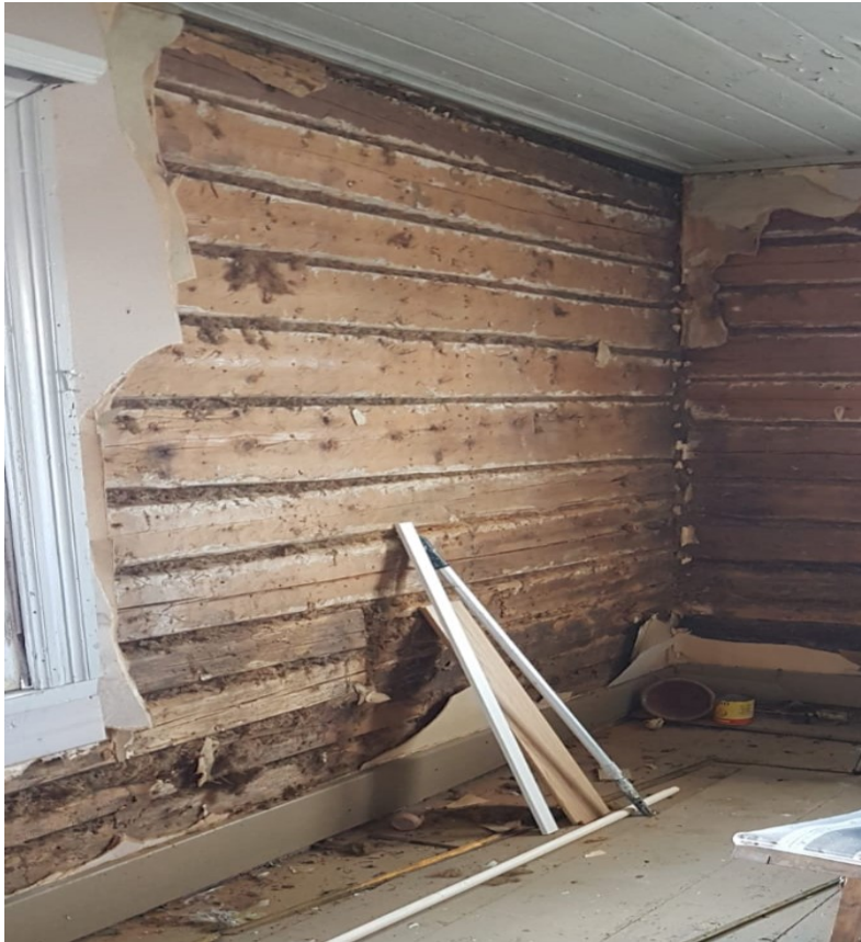
Kuva 40. Pinkopahvit ja tapetit poistettiin rungon arviointia varten. Kuvassa on pohjoisen puolen kamari.
