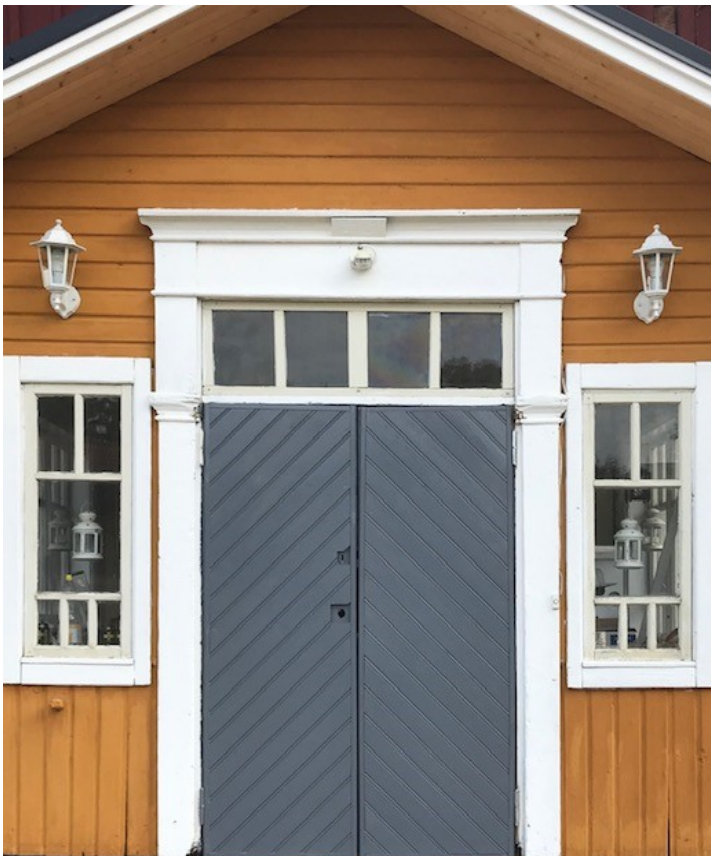
Kuva 68. Vanha ovi jää paneloinnin sisään.
