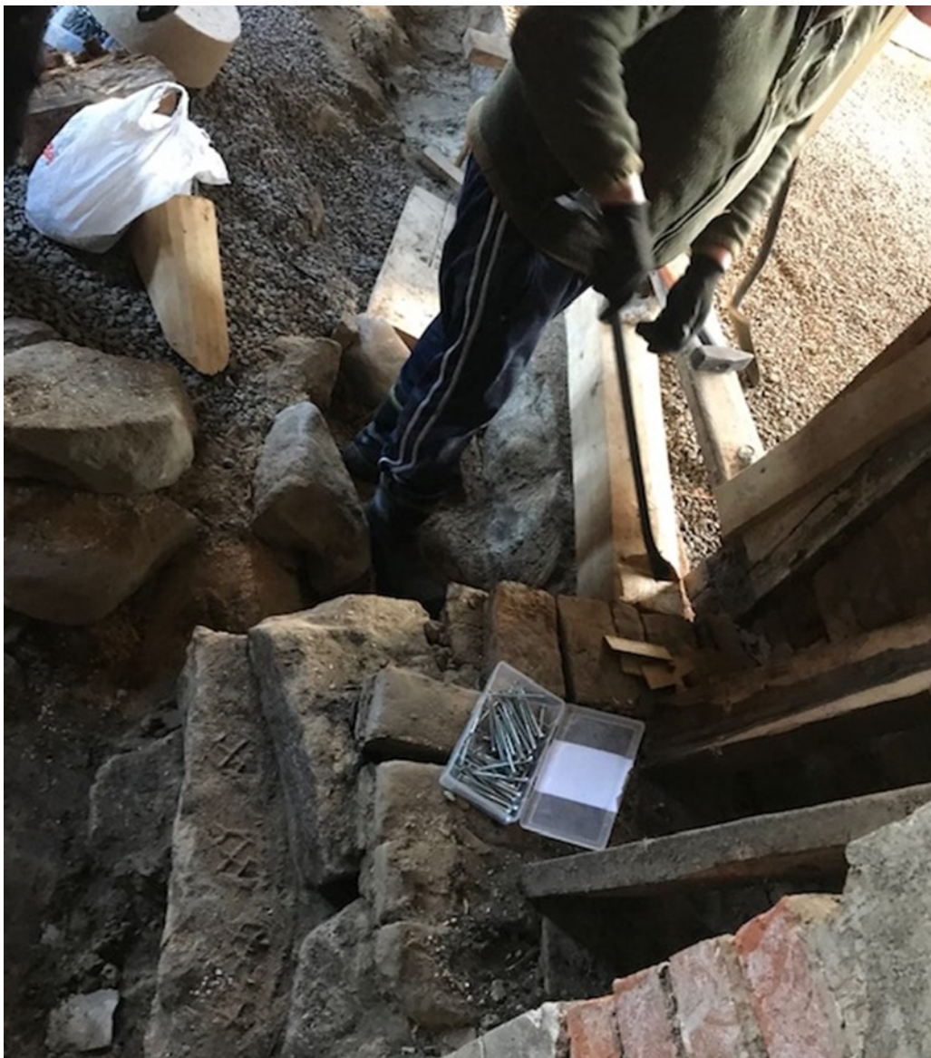
Kuva 51. Murskepatjojen asentamisen yhteydessä viimeisteltiin vielä hirsirungon korjauksia.
