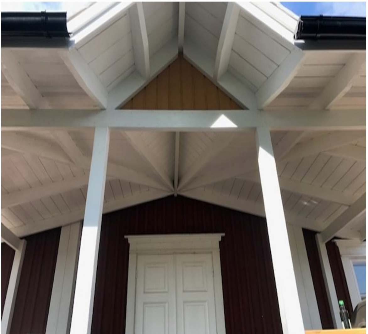
Kuva 76. Uuden kuistin alakaton rakenteet.
