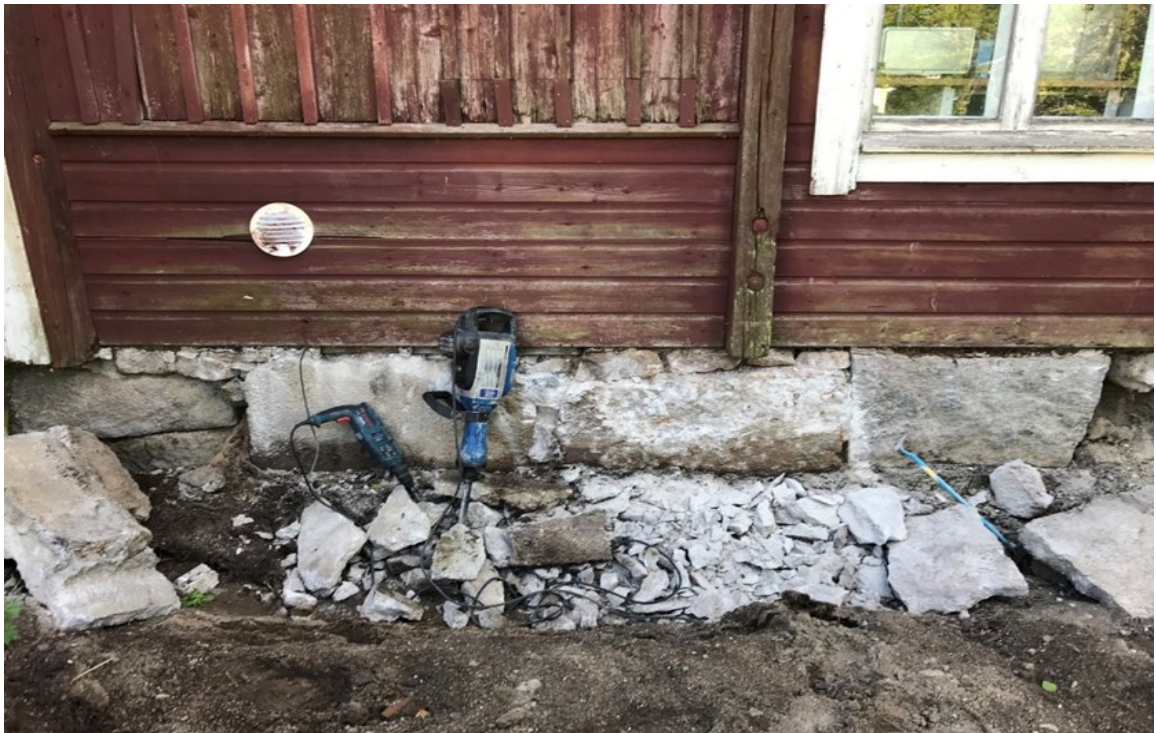
Kuva 49. Betonimanttelin purku piikkaamalla.
