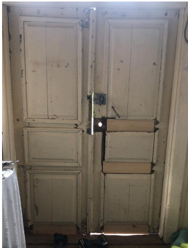
Kuva 35. Ulko-ovi sisäpuolelta kuvattuna.
