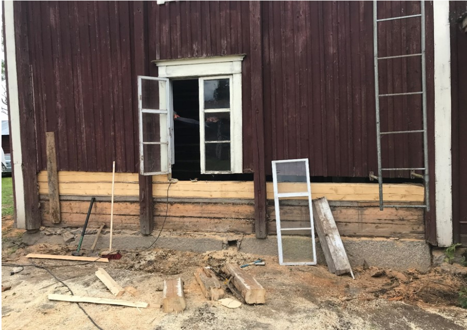
Kuva 54. Hirsirungon korjausta pohjoisseinällä, joka oli jo aikaisemman korjauksen yhteydessä kengitetty.
