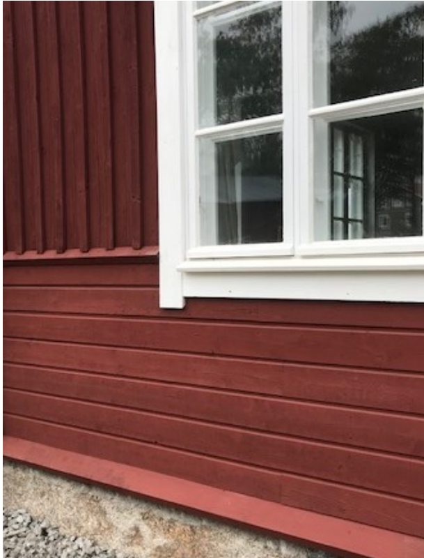
Kuva 59. Pohjoisseinällä vanha rimalaudoitus ja uusittu vaakaponttilaudoitus sekä uhrilaudat.
