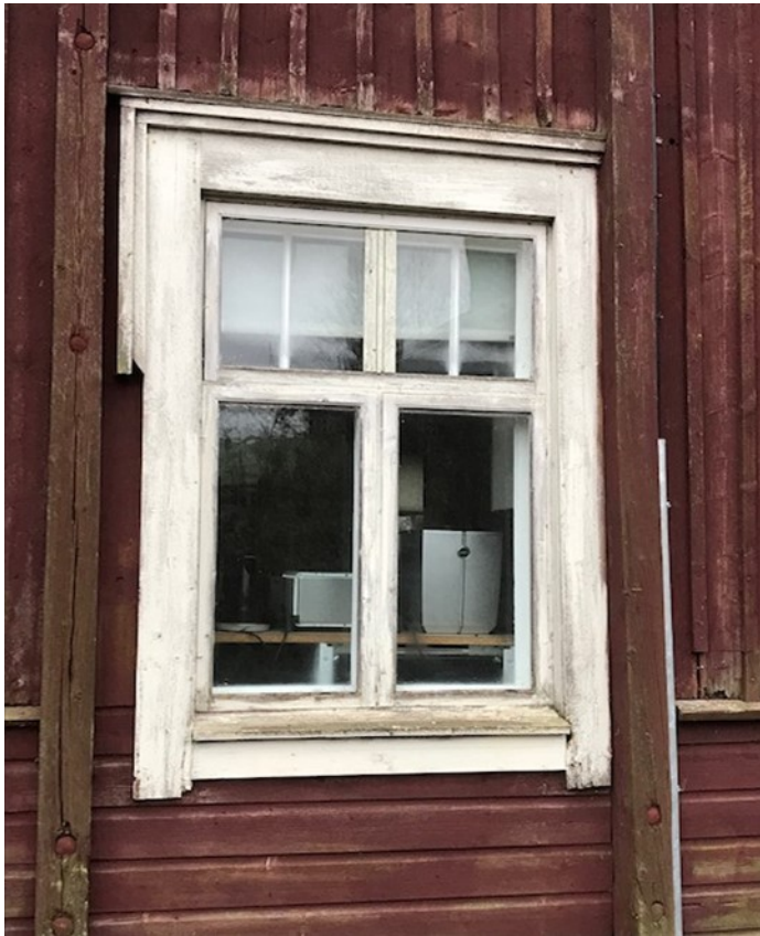
Kuva 32. T-ruudutus talon eteläpäässä. T-ikkunat olivat ilman empirekoristetta eli ikkunakruunuja.
