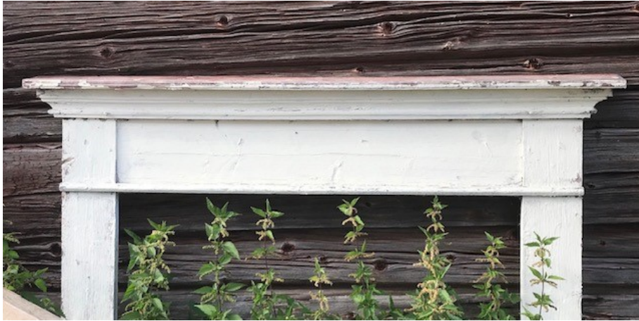
Kuva 62. Vanha ikkunakoristete säilytettiin malliksi.
