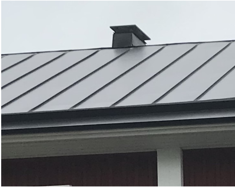
Kuva 72. Katto jalkaränneineen ja aluslaudoituksineen valmiina.
