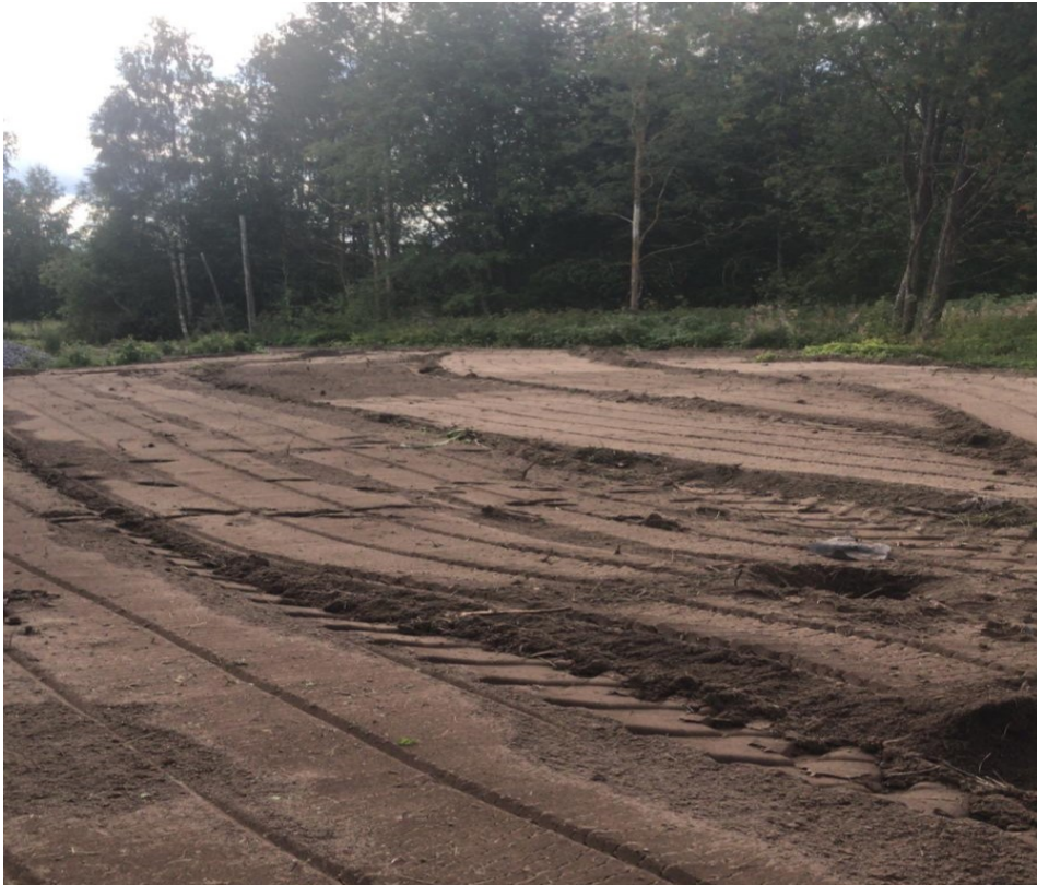
Kuva 48. Nurmialueiden rakentaminen jyrksimellä.
