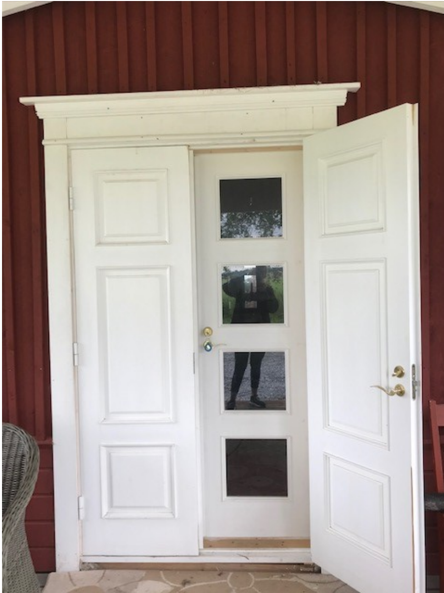
Kuva 66. Uusi pariovi kruunuineen valmiissa seinäpinnassa.
