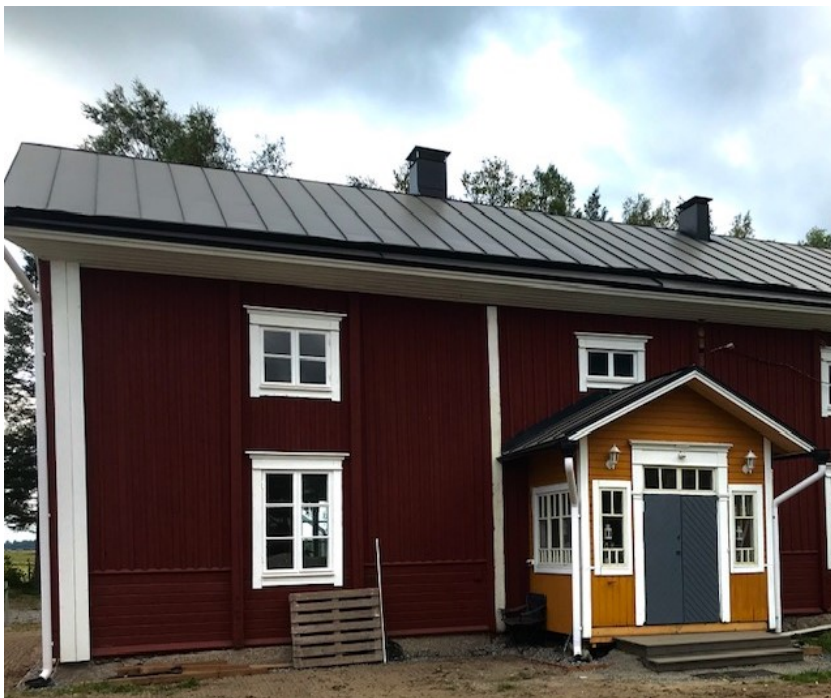
Kuva 103. Pohjoiseen, itäpäädyn korjaukset valmiina.
