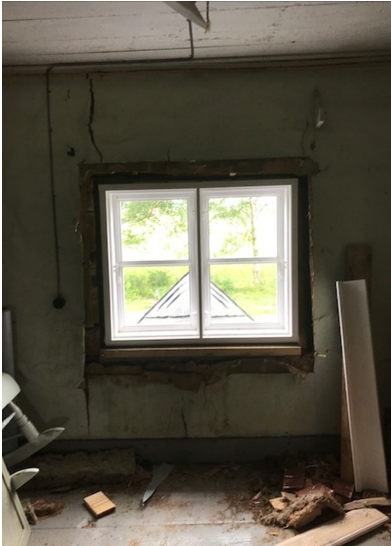
Kuva 95. Uusi ikkuna on asennettu siten, että tilaan tehtävien pintatöiden yhteydessä se tiivistetään vasta pellavarieveellä.
