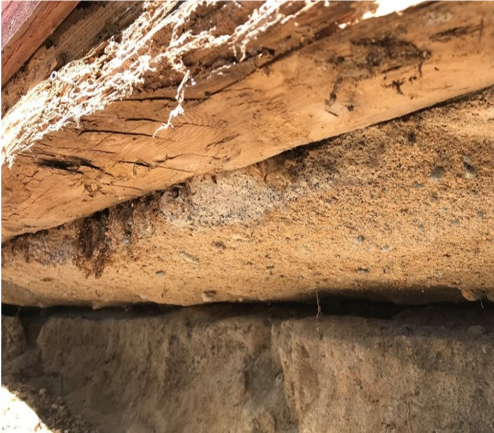
Kuva 20. Länsipäädyn alapohjan "roskavalu" 1970-luvulta.
