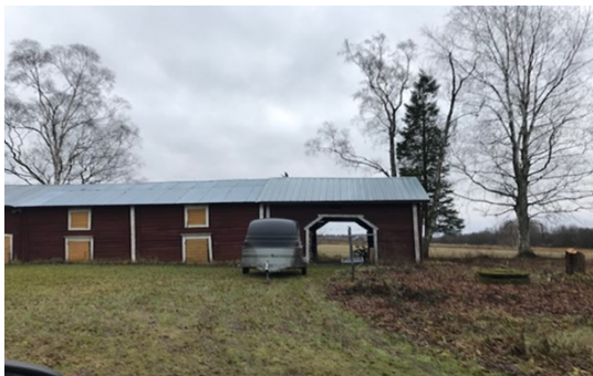
Kuva 11. Ulkorakennuksessa sijaitseva sola
