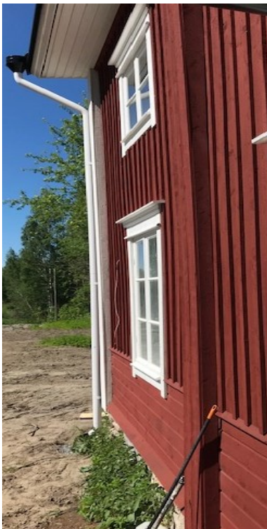
Kuva 55. Uusittu täkkihirsi ja kotelointi eteläsivun länsipäädyssä.
