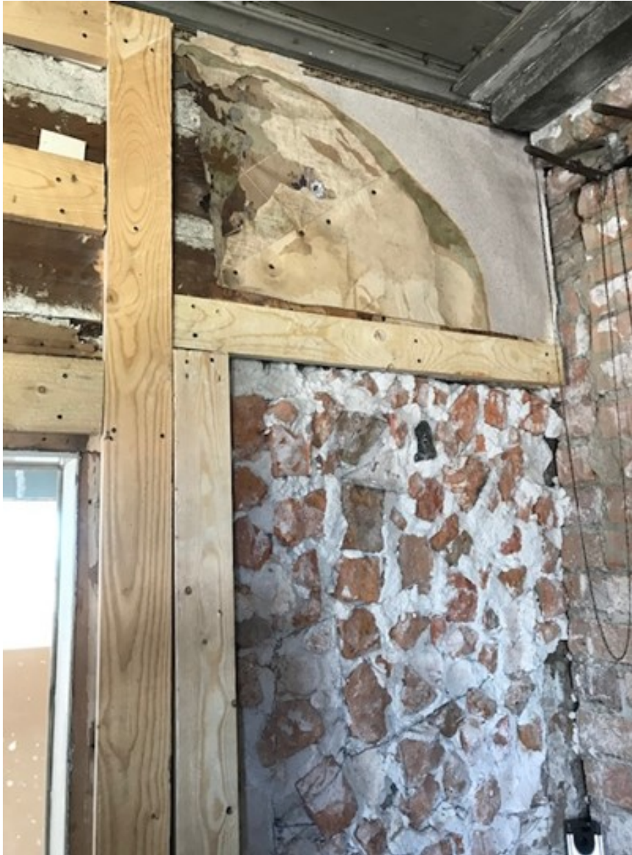
Kuva 88. Tapettifragmentin paikka. Kamarien välimuuri oli muurattu tiilenpalasista ja se jätettiin tasoituksen alle.
