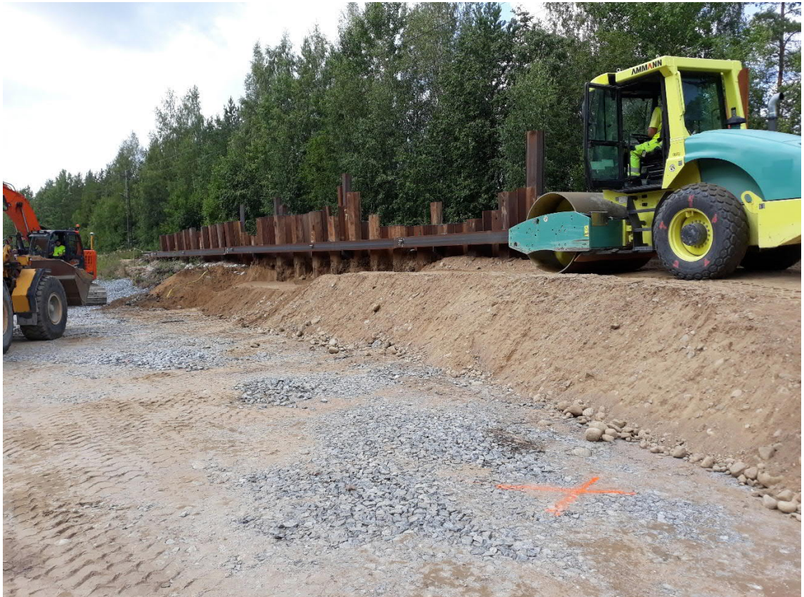
Kuva 18. Ammann ASC 70 yksivalssijyrä ja eristys- ja välikerroksen tekoa kaivurajoitusalueella. (Mika Lankinen)
