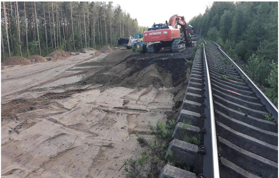
Kuva 20. Vanhojen rakennekerrosten kaivu liitosalueella (Mika Lankinen)
