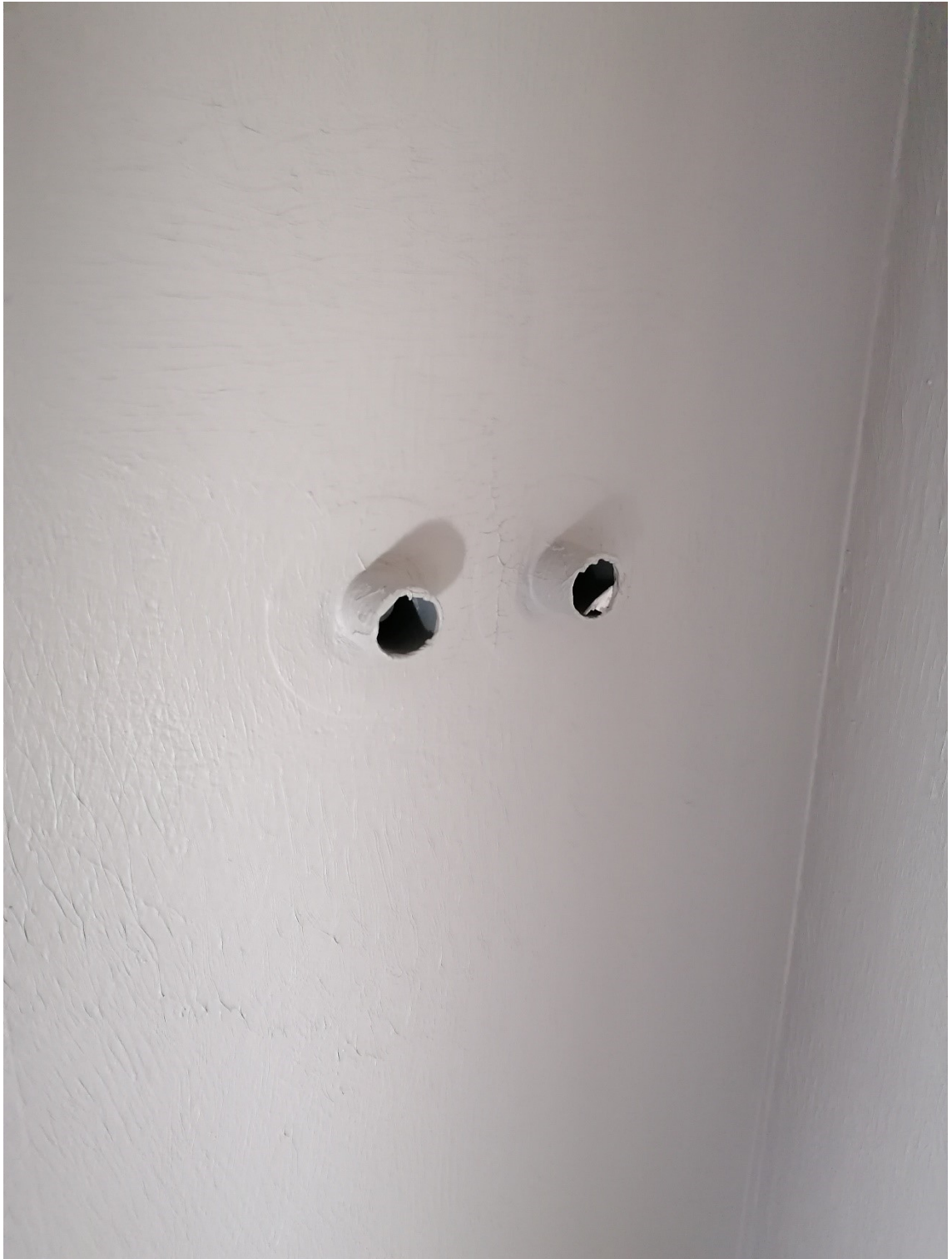
Kuva 3. Hanakulmien läpiviennit tehty vedeneristeeseen läpivientivahvikkeilla.
