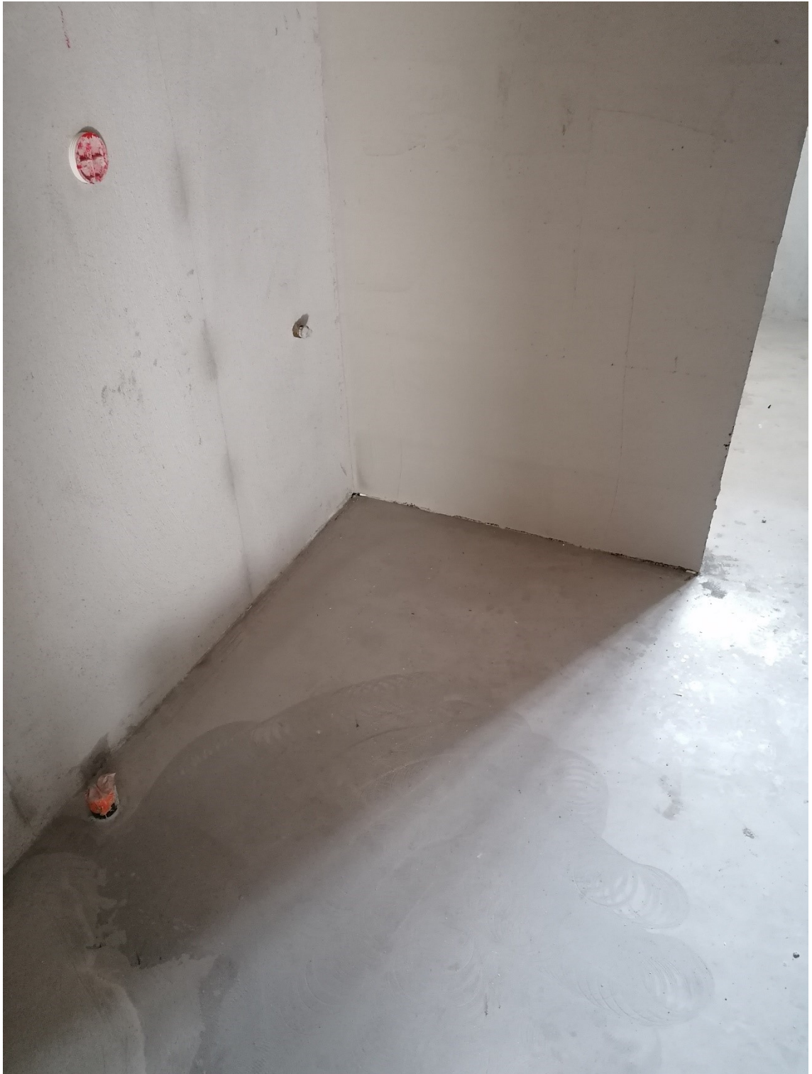
Kuva 1. Kylpyhuoneen pohjatyöt suoritettu.
