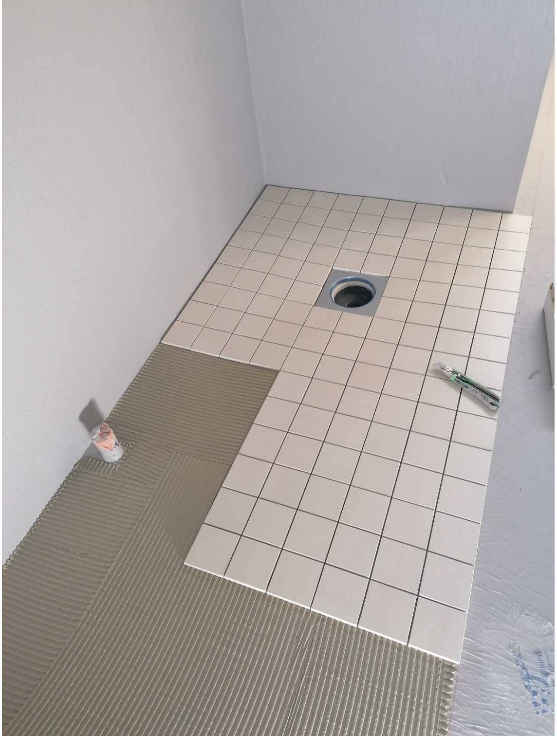
Kuva 4. Lattian laatoitustyö käynnissä. Lattialaatoituksen ja tulevan seinälaatoituksen väliin jätetty rako.
