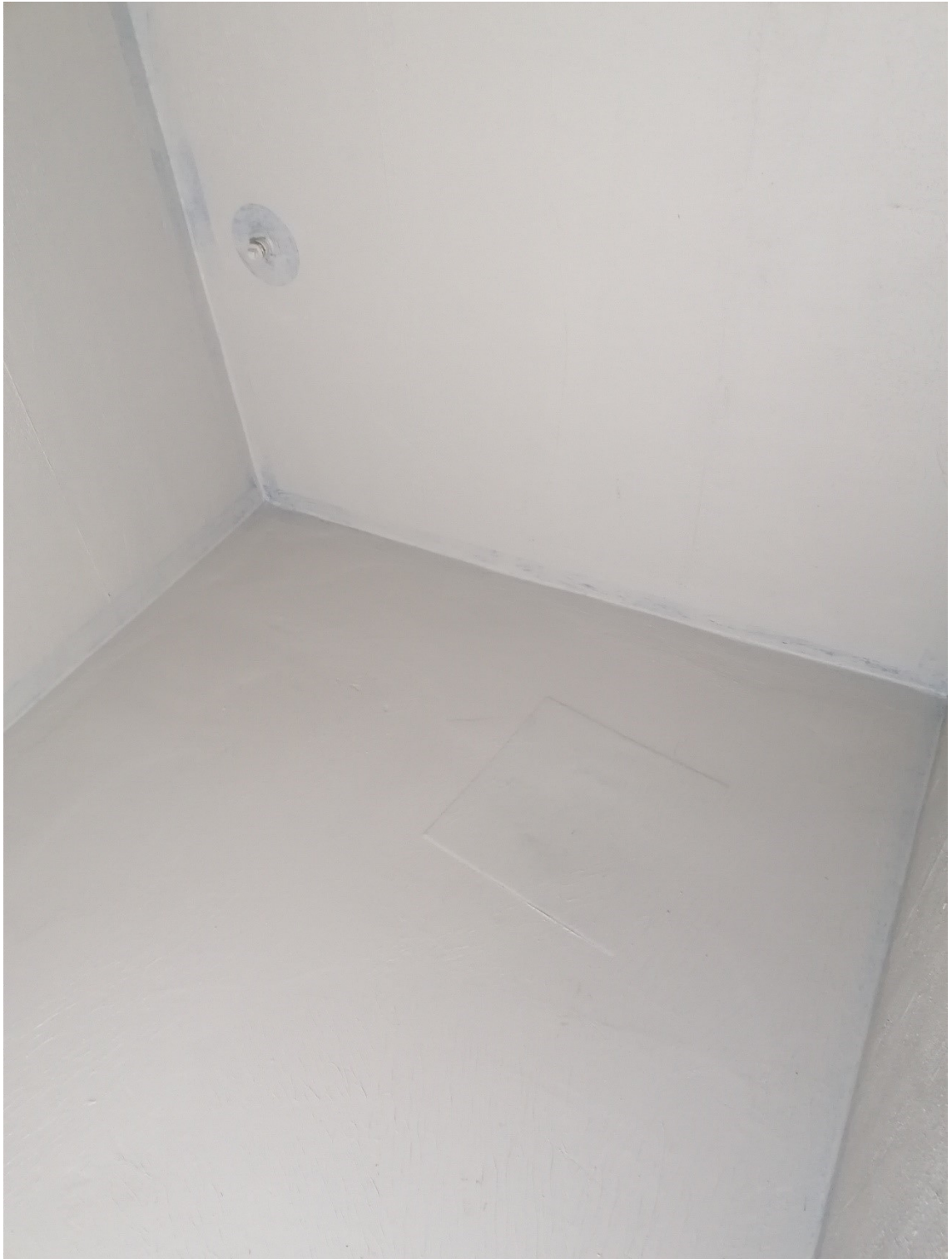
Kuva 2. Vedeneriste kuivumassa. Ensimmäinen kerros vedeneristettä levitetty.
